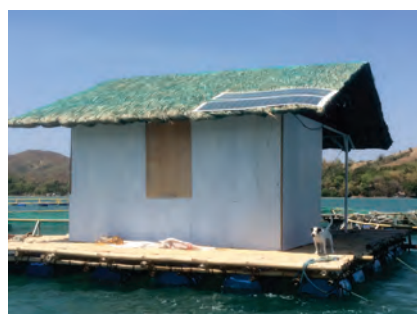
写真：屋根にパネルが乗っている
