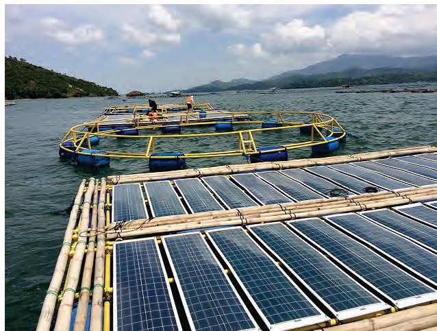
図 11 海上用太陽光発電システム
