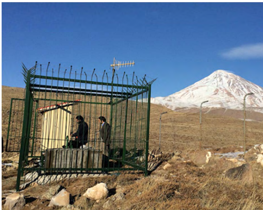
شکل 134.2 ایستگاه و تجهیزات EEW-1 در ورودی سد لار
