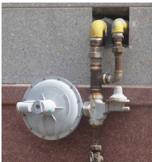
شکل 18.2.2 رگولاتور یک خانه برای کنترل فشار
