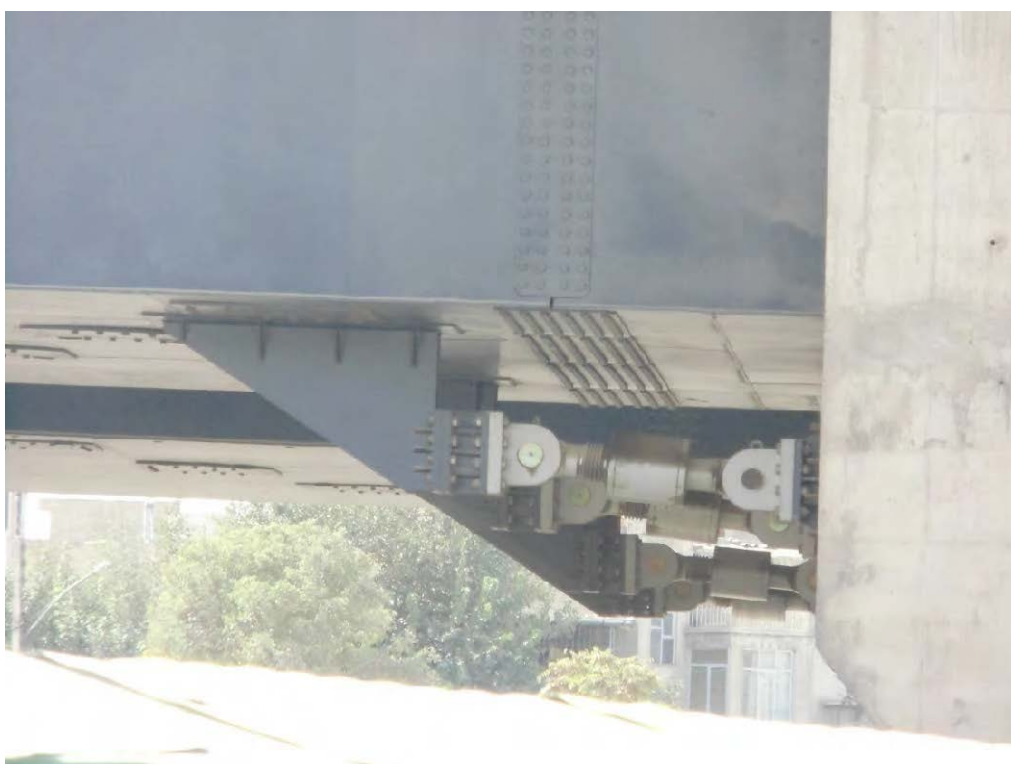
شکل 312.2 جداساز میراگر در انتهای شاه تیر
