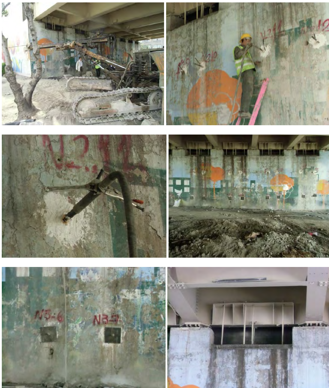
شکل 272.2 نمایی از وضعیت مقاوم سازی، چگونگی اتصال مهار، و وضعیت مقاوم سازی در تکیه گاه
