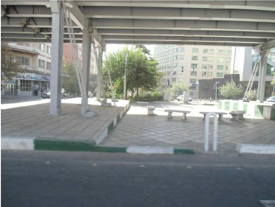
شکل 282.2 تصویری از مقاوم سازی لرزه ای انجام شده برای یک پل
