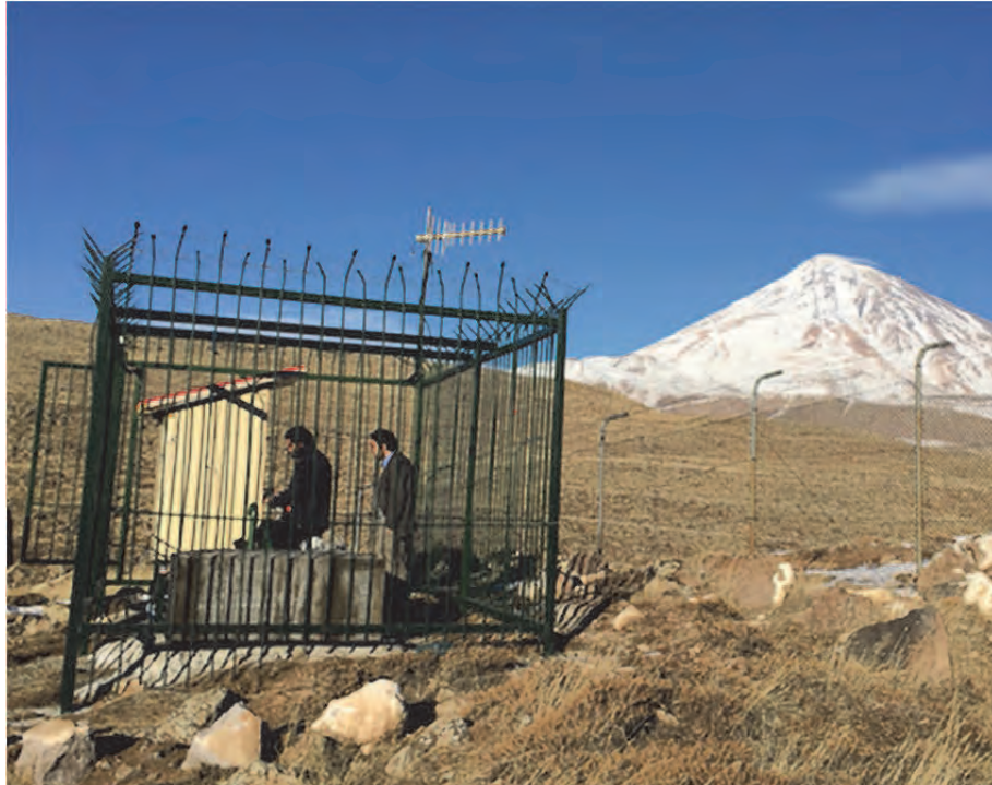
図 2.4.13 観測点施設 EEW-1(Lar Dam Gate)
