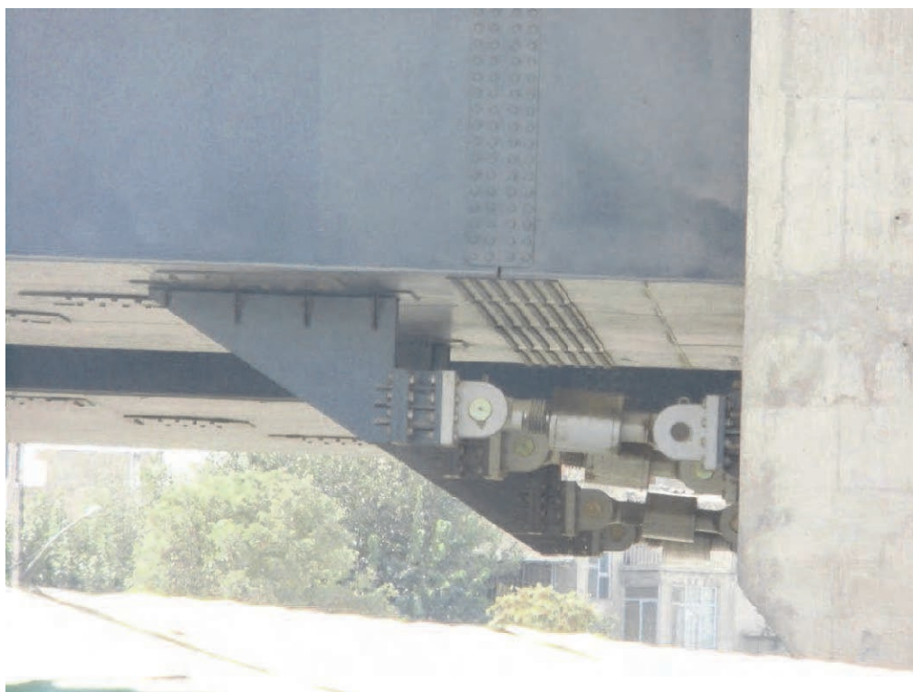
図 2.2.31 桁端部の粘性ダンパーの設置状況
