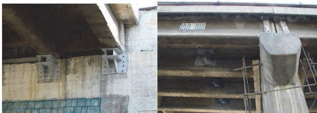
図 2.2.29 落橋防止装置、拡幅装置の設置状況
