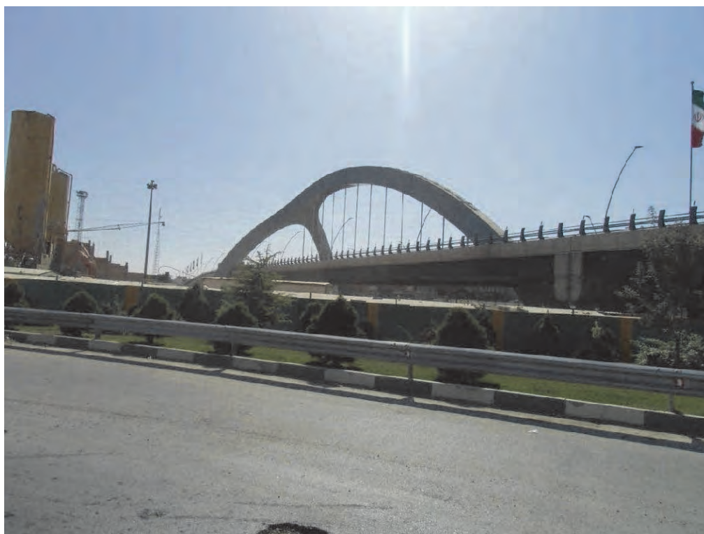
図 2.2.30 桁端部に粘性ダンパーが設置された橋梁
