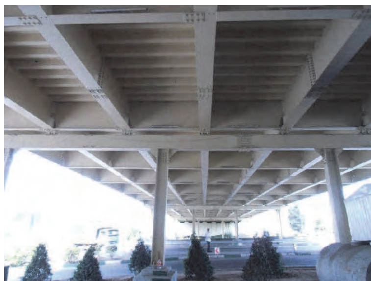
図 2.2.26 対象橋梁を桁下から撮影した写真
