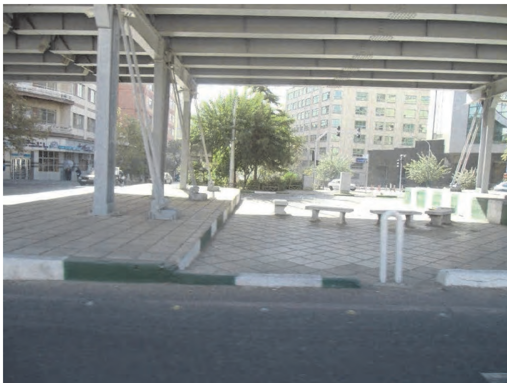
図 2.2.28 既に耐震補強対策が実施された橋梁
