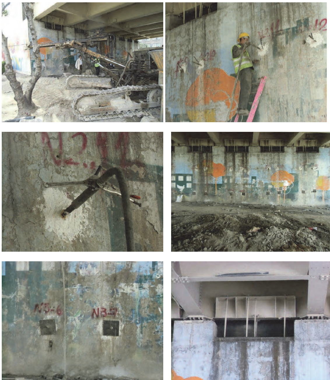
図 2.2.27 施工状況、アンカー設置状況、支承部補強状況
