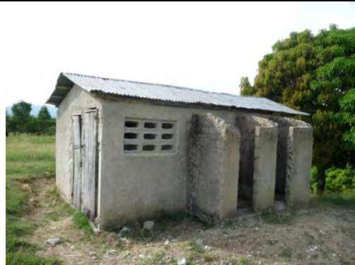
学校番号 3 既存トイレ棟(2014年10月25日) 老朽化が著しく、衛生的な管理がされていない。
