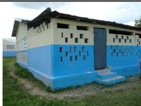
学校番号19 既存校舎(2014年10月26日) 教室不足から既存校舎に増築した教室。
