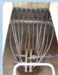
Скважина для отбора тепла
