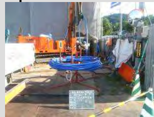
Установка геотермального теплообменника
