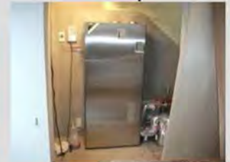
ヒートポンプ設置
