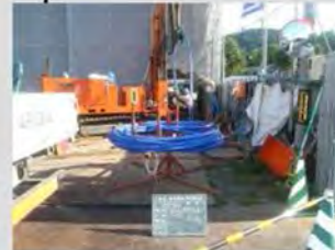
地中熱交換器挿入
