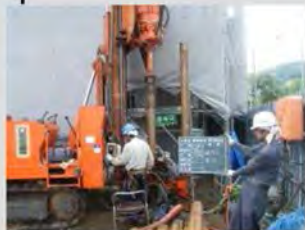
ポアホール削孔
