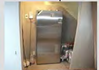
ヒートポンプ設置
