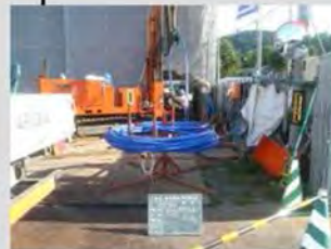
地中熱交換器挿入
