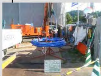
地中熱交換器挿入
