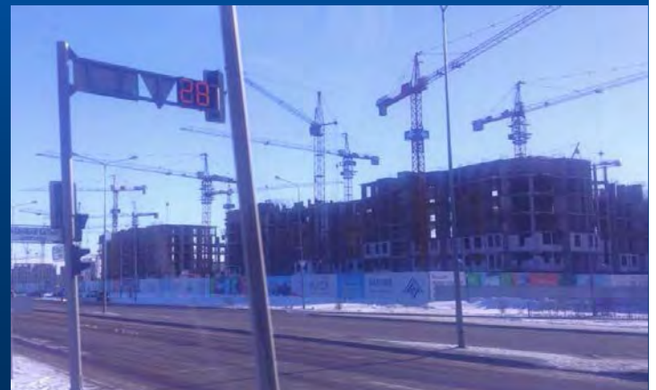
建設中の万博会場
