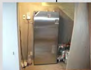
ヒートポンプ設置
