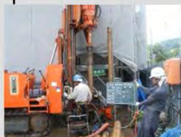
ボアホール削孔
