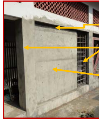
2) RC shear wall
