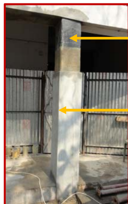
5) Carbon fiber wrapping
