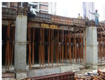
(d) Metal formwork and scaffolding
