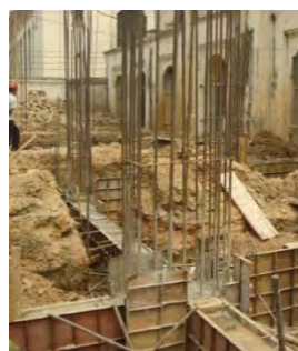
(b) 地中梁工事
