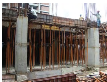
(d) 鋼製型枠と支保工
