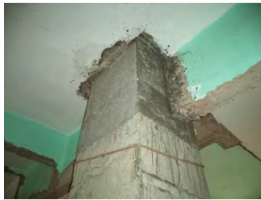
b) 1 階柱頭の無収縮モルタルの圧入
