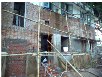
a) 壁配筋工事
