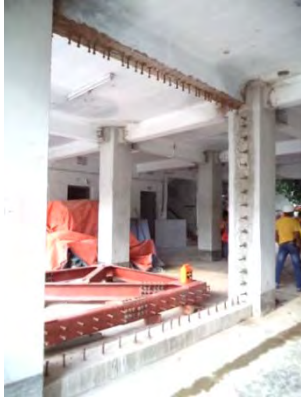
(a) 後施工アンカー取付け
