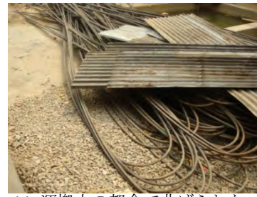
(c) 運搬上の都合で曲げられた長さ 12m 物の鉄筋
