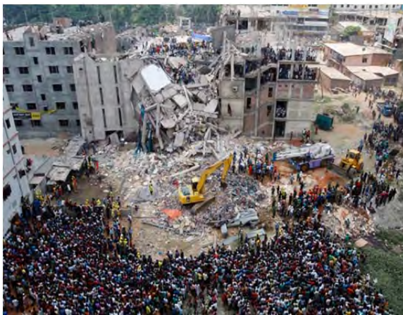
図 13 ラナプラザビルの倒壊事故状況
