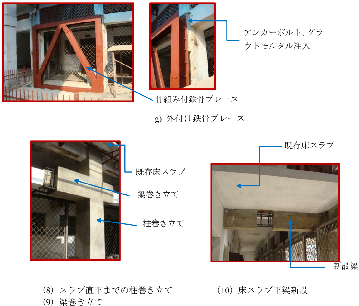
図 2.6.3 試験施工（第2年次）の4つの耐震改修工法
