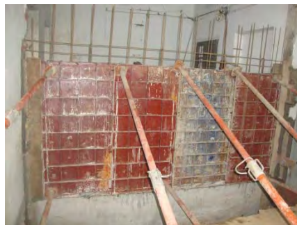
(a) RC 壁の型枠工事
