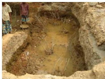
(a) 場所打ちコンクリート杭の杭頭鉄筋処理
