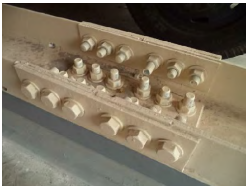
e) 鉄骨骨組み付ブレース
