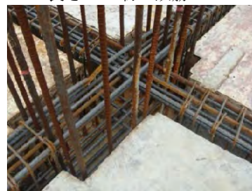
(e) 柱梁接合部部分の配筋状態
