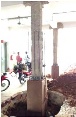
a) 地上階の配筋とコンクリート工事
