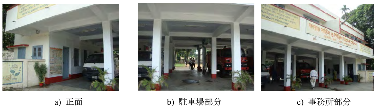
写真 2.10.2 建物（Fire Service and Civil Defense Station）外観
