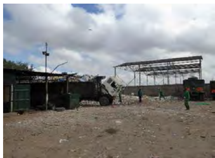
写真 2-28 ごみの積み替え施設
