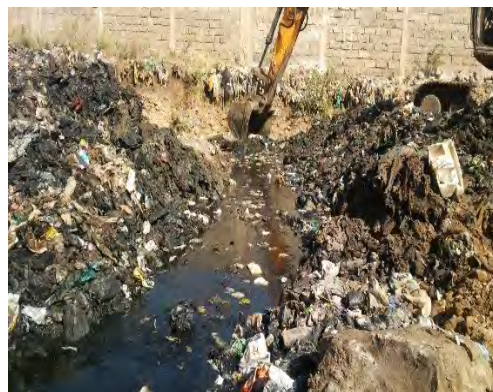
写真 2-3 ドレーン作成により路盤の排水を実施
