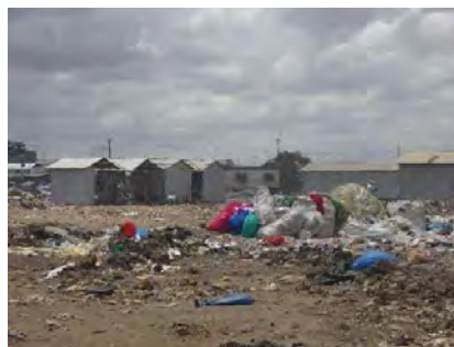
写真 2-18 処分場内に建設が進む住宅
