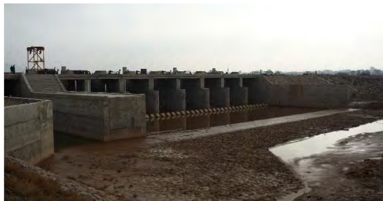
図 3.2.5 Aji Chay 川の比較的古い農業用取水堰と灌漑水路
