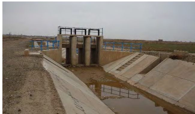
図 3.3.1 Tabriz より南側で開発中の灌漑システムの水路と分水施設（Aji Chay 川流域内）
