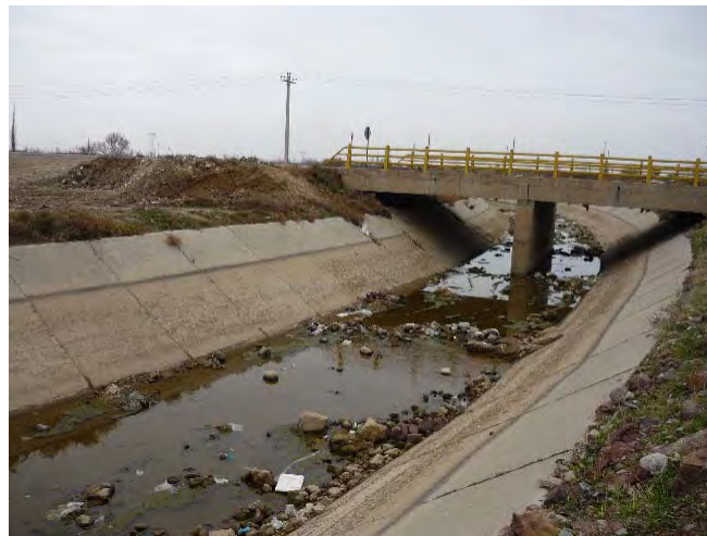
図 3.3.2 Zarineh Rud 川右岸エリアの Bukan ダムから農業用水の供給を受ける灌漑水路
