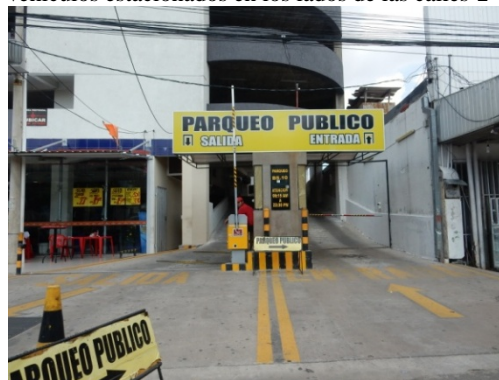
Ingreso a un parqueo multiniveles
