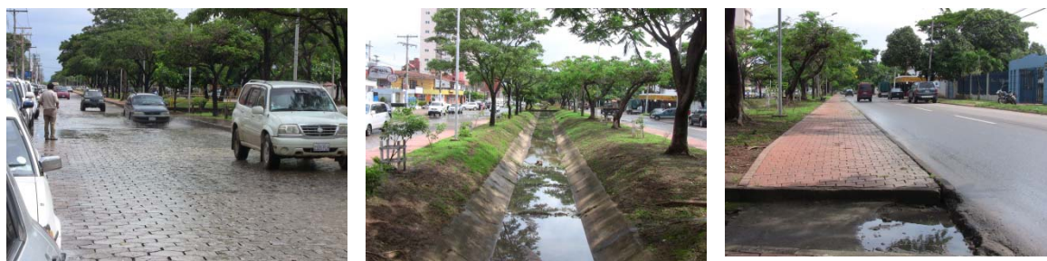
a) Carril izquierdo del Centro de la Ciudad b) Canal Central de Drenaje c) Carril Derecho del Centro de la Ciudad
