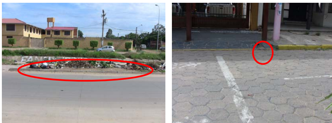
a) Vertido ilegal de basura en un canal abierto de drenaje b) Drenaje de agua pluvial de un Edificio Privado.
