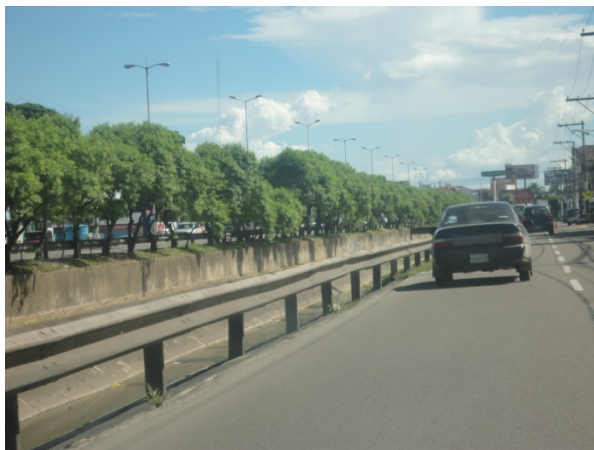
Figura 4.12 Canal de evacuación de lluvias en segundo anillo y su efecto barrera
