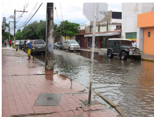
a) Inundación pluvial en una calle pequeña vista desde el primer anillo.
