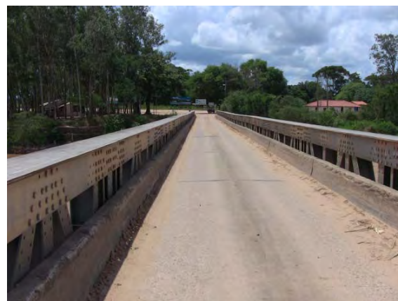
b) 1983 年洪水での落橋後に復旧された部分
