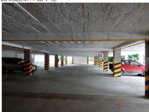
立体駐車場内の様子
