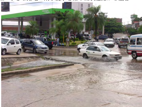
c) 雨水が道路から排水開水路へ流入している様子
