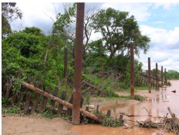
a) ピライ川と第 8 環状道路沿い主要排水開水路の合流点付近にある河岸侵食対策としての透過水制
