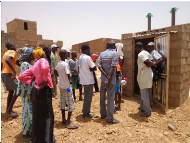
建設されたトイレの仮引渡し マタム州アニヤム・パラナベ村(2014.04)
