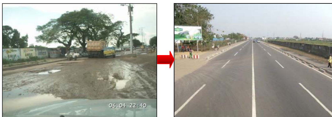
写真 1.6 ポワ・ルー通り状況（施工前、施工後）
