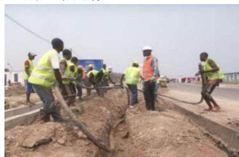
写真 2.2 太い電線が20,000V、細い電線が6,600V
