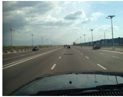
写真 1.8 太陽光式による LED 街路灯
