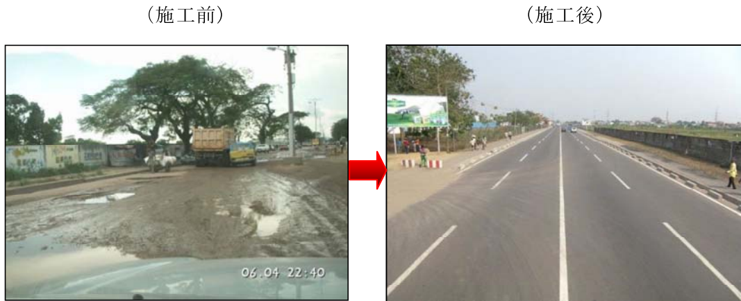
写真 1.6 ポワ・ルー通り状況（施工前、施工後）
