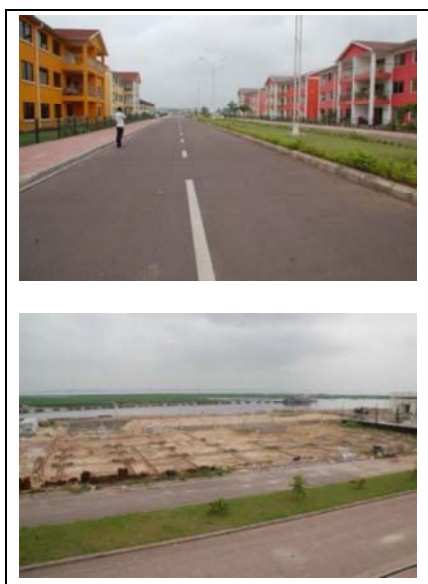
写真 2.1 宅地開発状況
