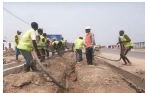
写真 2.2 太い電線が 20,000V、細い電線が 6,600V
