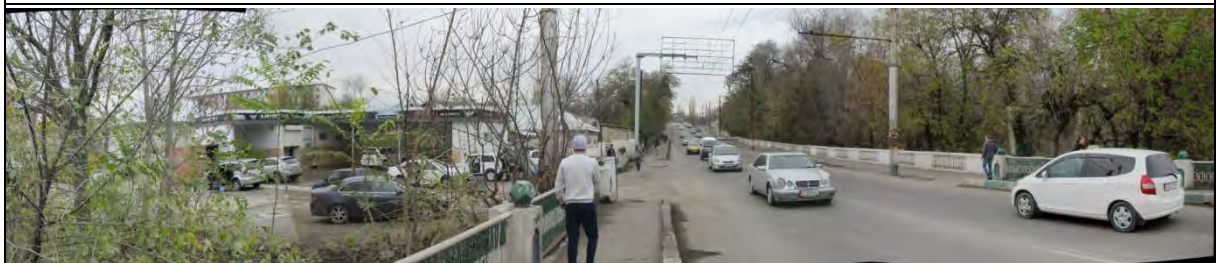
c 橋梁終点側（西端）より終点側交差点方向を望む
