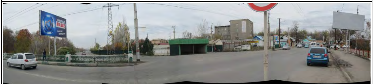
b 橋梁起点側（東端）より起点側交差点と空港への北上道路を望む
