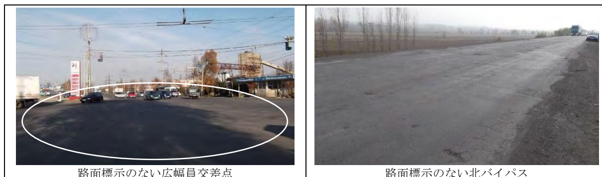
路面標示のない広幅員交差点
