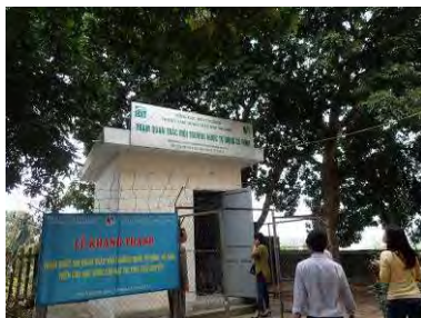
自動モニタリング装置建屋
