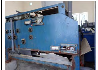
スラッジ処理装置
