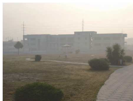
写真 2-1 ICT センタービルの建設
