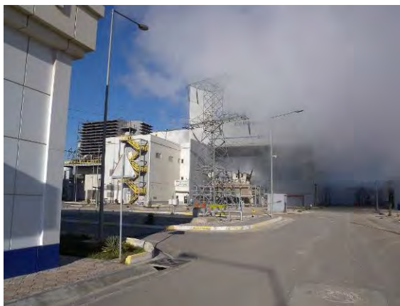
図 3-8 GT 吸気側に流れる冷却塔の湿空気
