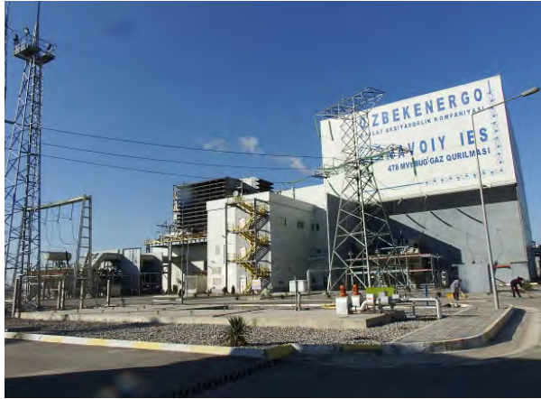
写真 1 ナボイ火力発電所コンバインドサイクル発電 設備 (CCPP) 1号機タービン建屋全体
