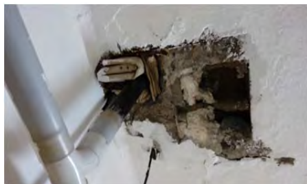
Orificios abiertos bruscamente para la tubería
