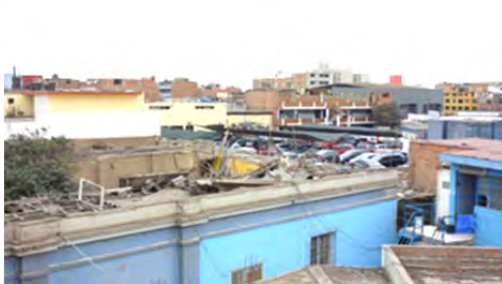
Terreno planeado para reconstrucción
