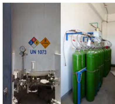
Tanques de gases de uso médico (oxígeno, aire y de succión)
