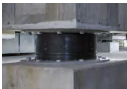
Ejemplo de colocación de la unidad de aislamiento
