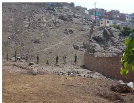
Rocas inestables y viviendas vecinas en el cerro trasero del terreno previsto para la reconstrucción
