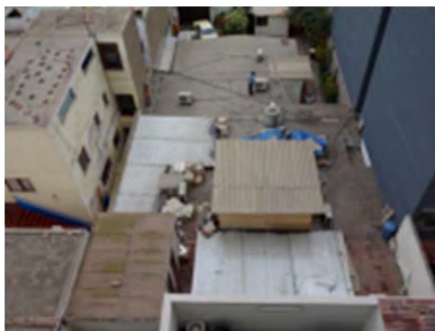
Vista panorámica del pabellón de farmacia desde el pabellón principal (no hay conexión entre los edificios de altura mayor y menor)
