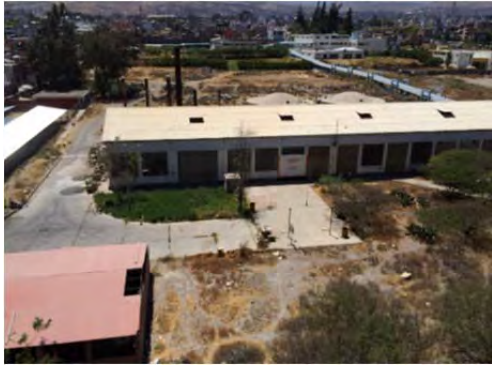
Vista panorámica de la sala de calderas desde la azotea del pabellón de hospitalización. Se aprecia muchos espacios vacíos
