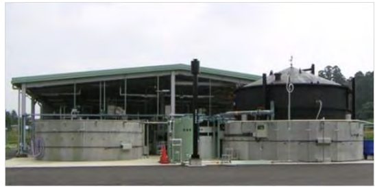
写真 2-4 バイオマスプラント
