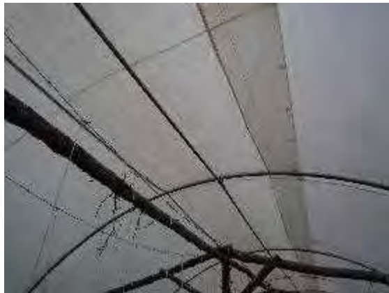
ハウス上部（ビニール閉め切り時）
