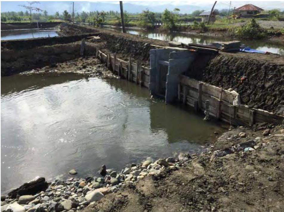
図 4-19 Pond L の水門整備と Pond L-Pond C 間の堰き止め
