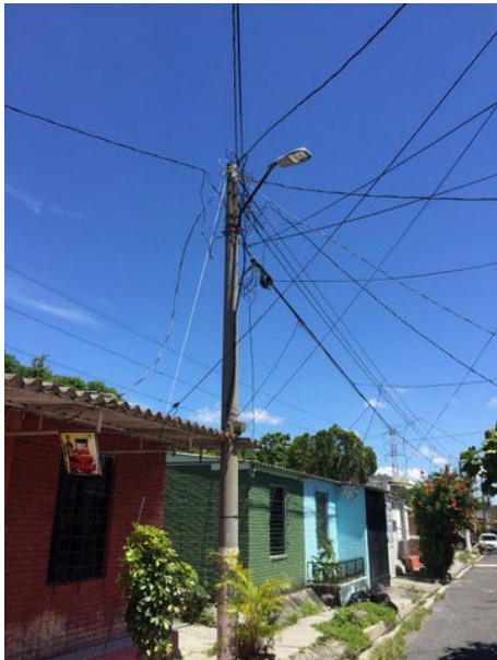
Foto 2-3 Lámpara de LED instalada (de día)
