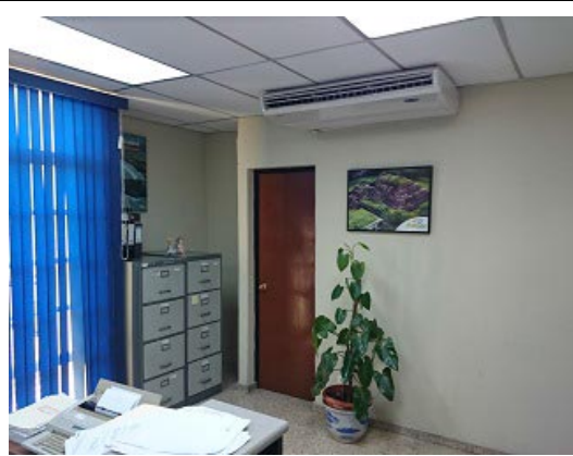
写真 2-6 セクション B 内部
