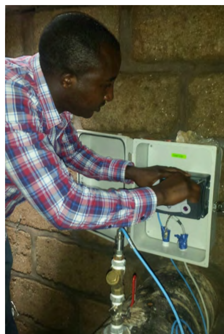
写真 2. 無収水対策のための機材を設置している様子
