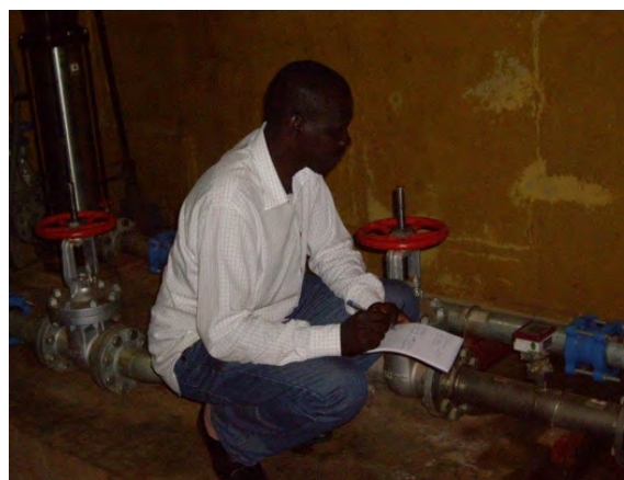
写真 4. 無収水対策のためにメーターの検針をしている様子
