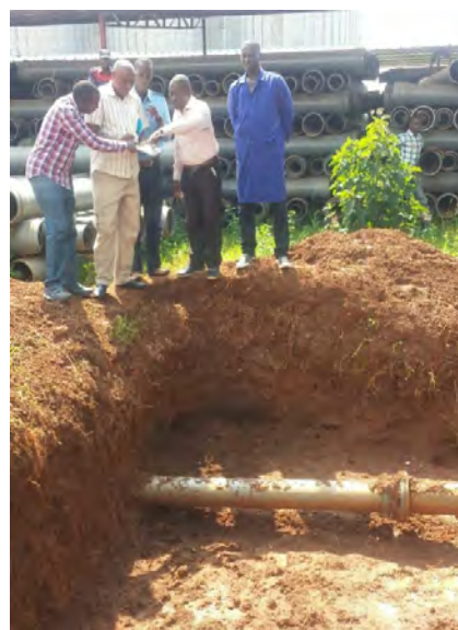
写真 1. 破損した水道管の交換を準備している様子
