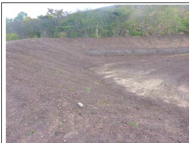
Foto E4.2: Situación del bolsillo de la cuenca de retardamiento de sedimentación. MOPTVDU realiza anualmente la gestión de mantenimiento (Mar. 25, 2015)
