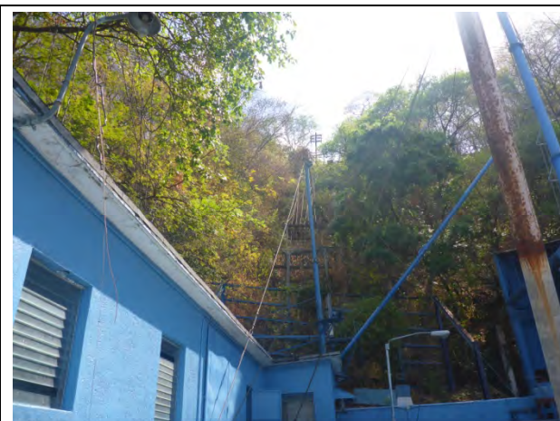
Foto N3.5: Pendiente en la parte trasera del objeto de conservación. La inclinación de la pendiente es de aprox. 45° y la longitud de la pendiente es de aprox. 120m (Mar.13, 2015)
