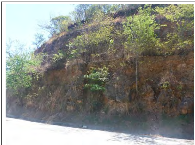
Foto E6.1: Pendiente 9, Pendiente al costado derecho (Alto de la pendiente 10m, ancho 400m, en algunas partes cuenta con altura 20m, ancho 100m) (Feb. 19, 2015)
