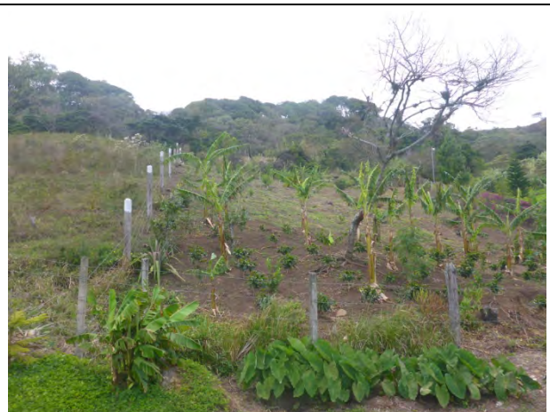
Foto N4.3: Situación de las cercanías a los extremos Tomado de la parte inferior. Permanecen en la ladera de la pendiente suelos inestables y terrones. (Mar.16, 2015)
