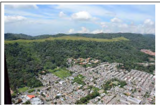
Foto E2.5: Situación de la eliminación de la tierra en la parte superior, Foto suministrada por el profesor FUKUOKA, Hiroshi
