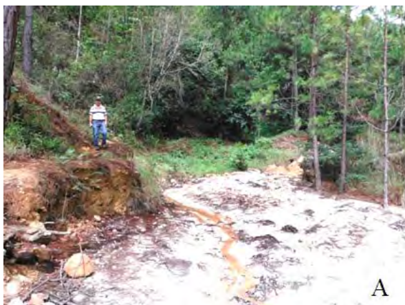
Foto H3.4: Situación del extremo del deslizamiento (Febrero 23 de 2015)
