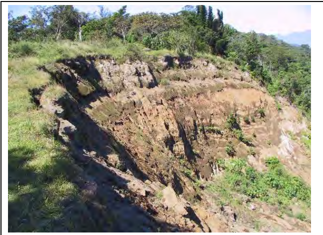
Foto E2.2: Situación de la parte superior, Foto suministrada por el profesor FUKUOKA, Hiroshi
