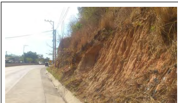
Foto E5.7: Pendiente 4, Sedimentación piroclástica eólica fácil de erosionar (Mar. 14, 2015)
