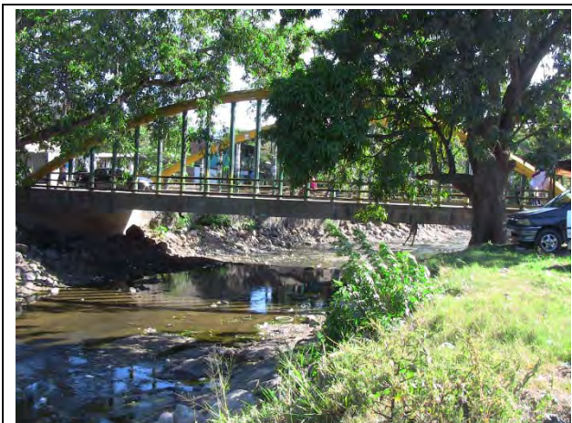
Foto N8.3: Viviendas a los largo del río Grande. Daños por pérdidas de la corriente en el año 2014.
