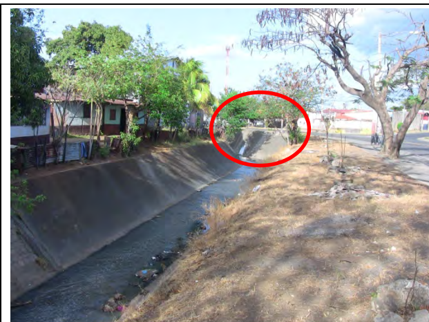
Foto N7.4: Parte curva en el curso medio del Canal Oriental: Se desbordan a la carretera de la ciudad las crecientes repentinas.
