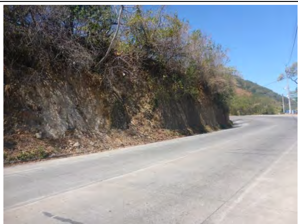
Foto E6.7: Pendiente 5, Pendiente al costado derecho (Alto de la pendiente 10m, ancho 100m) (Feb. 19, 2015)
