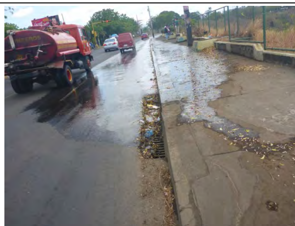
N5.4: Situación del canal al costado de la vía (Mar.13, 2015)
