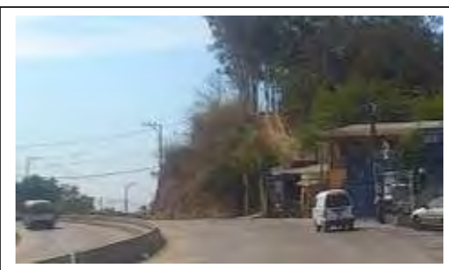
Foto E5.6: Pendiente 4, pendiente al costado del carril de bajada (Altura máxima de la pendiente 15m, altura promedio de la pendiente 10m, longitud total de la vía de la pendiente 140m), pendientes de tierra eólica, longitud de superficie 17km+600m (Mar. 14, 2015)
