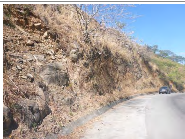
Foto E6.12: Pendiente 1, Pendiente al costado derecho (Alto de la pendiente 25m, ancho 100m) (Feb. 19, 2015)
