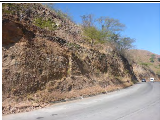
Foto E6.11: Pendiente 2, Pendiente al costado derecho (Alto de la pendiente 20m, ancho 200m) (Feb. 19, 2015)
