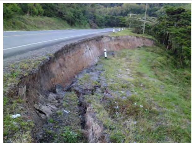
Foto N4.1: Situación de la parte superior del deslizamiento. Se encuentra un socavón de 70m de ancho. Recibida por FOMAV (Desconocida la fecha de la toma) (Mar.16, 2015)
