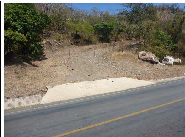
Foto N1.15: Rastro de la vía provisional (Mar.16, 2015)
