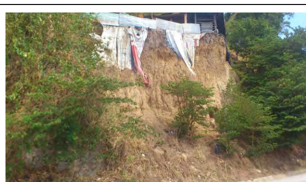
Foto E5.10: Pendiente 6, pendiente al costado del carril de bajada (Altura máxima de la pendiente 11m, altura promedio de la pendiente 10m, longitud total de la vía de la pendiente 75m), pendientes de tierra eólica, longitud de superficie 18km+000m (Mar. 14, 2015)
