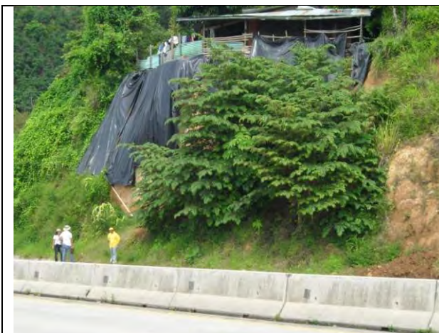
Foto E5.14: Se presentaron derrumbes en la pendiente y se instaló cobertura negra como obra estratégica de emergencia.
