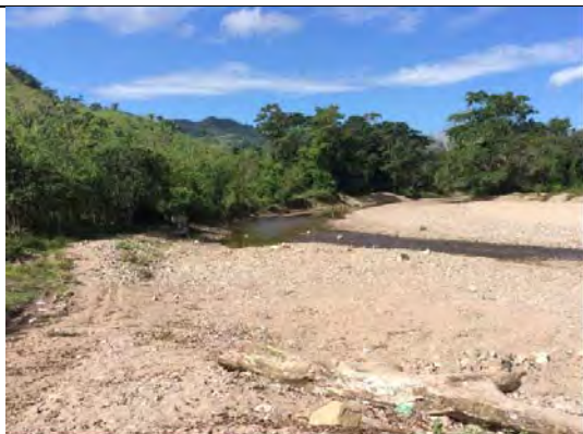
Foto H7.1: Lado de la cuenca superior del puente Pires. El contrafuerte del lado Pires se encuentra mirando hacia el lado de la corriente.
