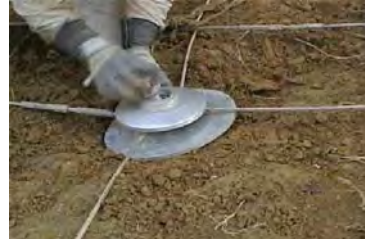
Obra de la parte superior
