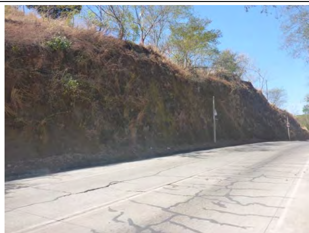
Foto E6.8: Pendiente 4, Pendiente al costado izquierdo (Alto de la pendiente 20m, ancho 170m) , pendiente al costado derecho (Alto de la pendiente 20m, ancho 150m) (Feb. 19, 2015)
