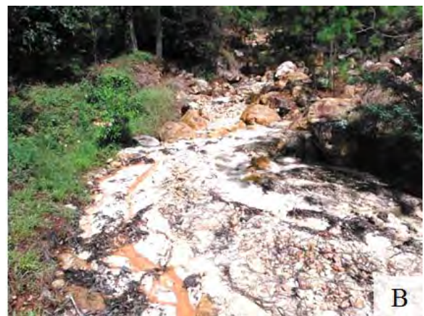
Foto H3.5: Situación del extremo del deslizamientos (Febrero 23 de 2015)
