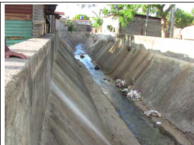
Foto N7.6: Cercanías del Curso superior del Canal Oriental, Se encuentran viviendas en los dos costados.
