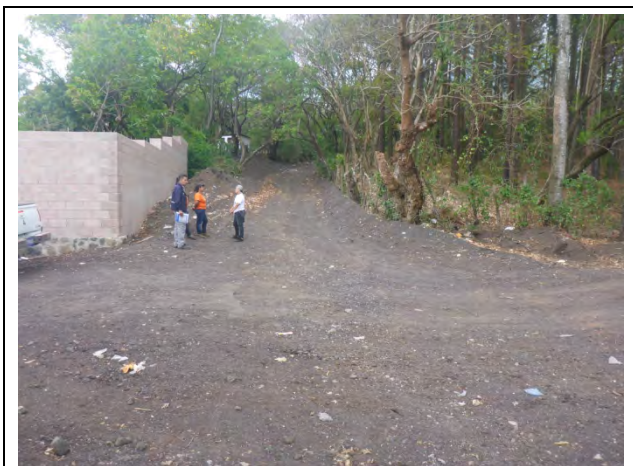
Foto E4.9: Se generan todos los años derrumbes en esta quebrada? (Mar. 25, 2015)
