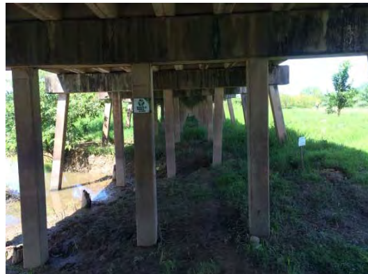
Foto H5.2: Puente Alivio del Aguan No. 4 Situación de los pilares del puente del lado Saba. Son pilares curvos, sin embargo al no ser rápida la corriente es estable.
