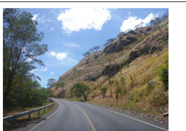
Foto N2.6: Situación de las vías Tomado desde el costado del punto final. (Mar.16, 2015)
