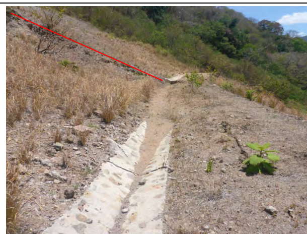
Foto N1.10: Cambio del lugar del canal de agua tercer canal de abajo hacia arriba (Línea roja al costado derecho del deslizamiento) (Mar.16, 2015)
