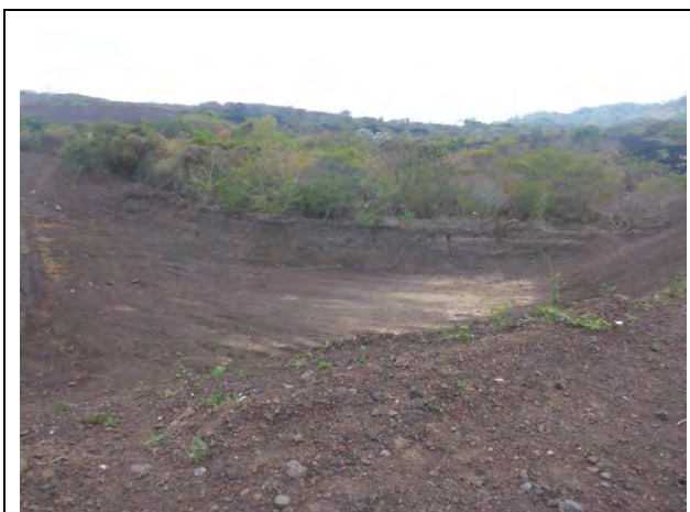
Foto E4.3: Situación del bolsillo de la cuenca de retiramiento de sedimentación. MOP realiza anualmente la gestión de mantenimiento, las cuencas han sido instaladas en aprox. 10 lugares (Mar. 25, 2015)
