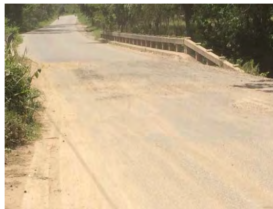
Foto H6.2: Puente Taujica Se encuentra reparada la superficie del puente rellenando la parte superior caída del puente.
