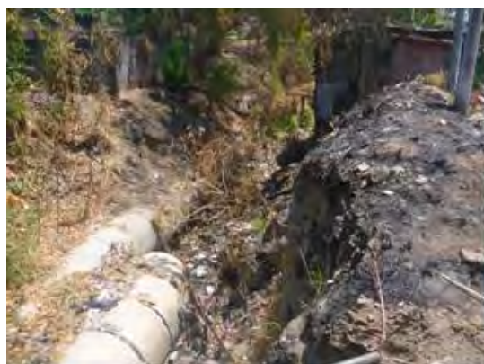
Foto E1.13: A lo largo de la vía Calle Principal, entre la 27 Avenida Norte y Boulevard Constitución. Situación de los Canales. Cuenta con estructuras de conductos subterráneos. No es suficiente su mantenimiento.
