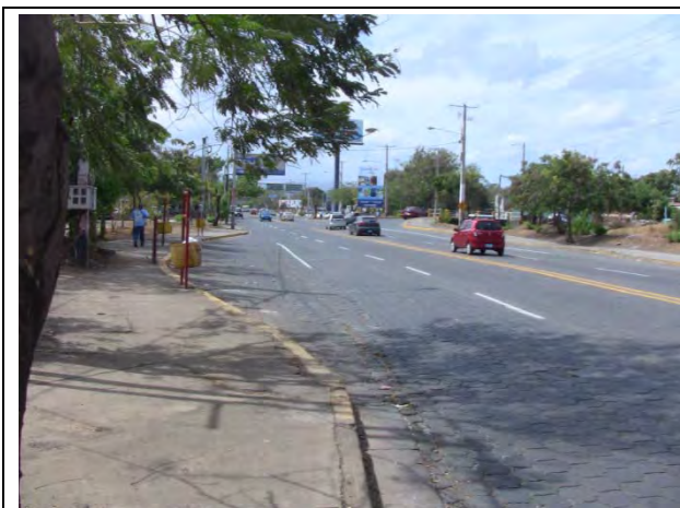
Foto N7.5: Pista Juan Pablo II paralela al Canal Oriental: Corre a gran velocidad la inundación desbordada debido a la inclinación del terreno.
