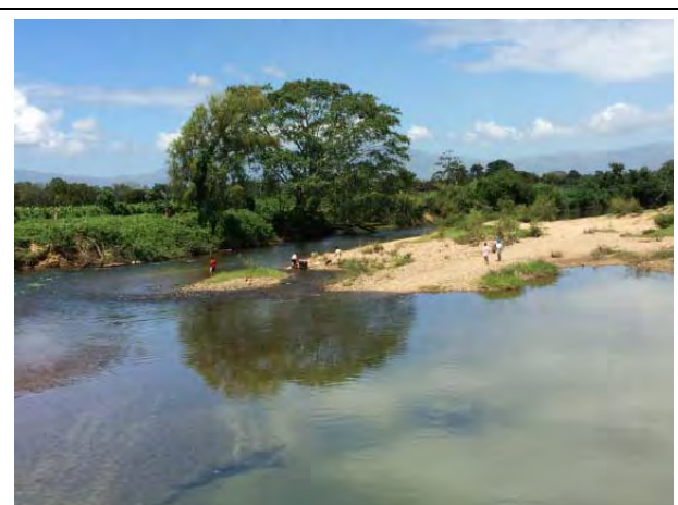
Foto H8.1: Puente Tocoa Situación de la sedimentación en el curso superior. Ha avanzado la sedimentación en la parte inferior de las vigas del puente. Debido a los efectos de la sedimentación del puente se han inundado las vías aledañas al puente Prieta del lado Saba.
