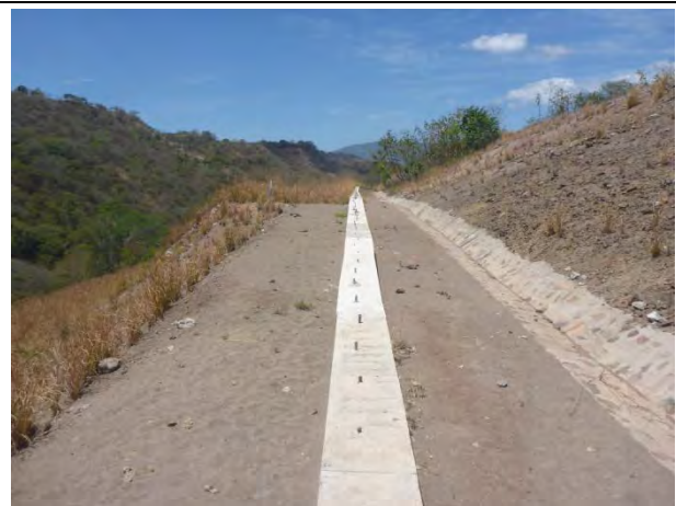
Foto N1.4: Puntos de ejecución de Micro pilas L=17m
