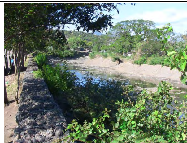
Foto N8.4: Río Grande: Ejecución de las excavaciones anuales del cauce desde el año 2011 y obras estratégicas ante la erosión de las orillas del río (Obras de cesta de serpiente).
