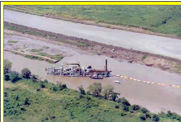
FotoH9.2: Dragado de los canales de drenaje de inundaciones Fuente : CCIVS(Comisión para el Control de Inundaciones del Valle de Sula)
