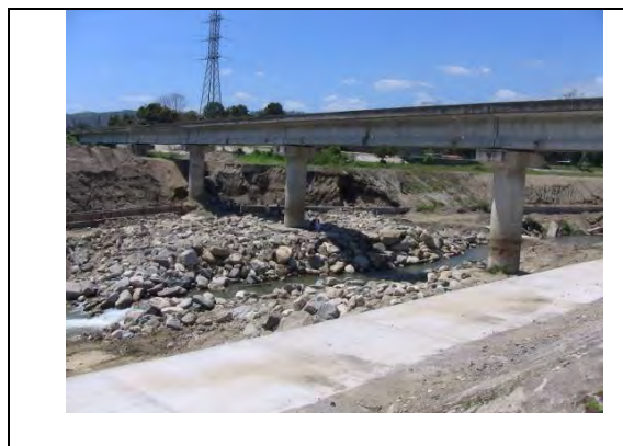
Foto 4.4.9: Puente férreo del río Choloma, construido bajo cooperación con recursos no reembolsables de JICA en el año 2002
