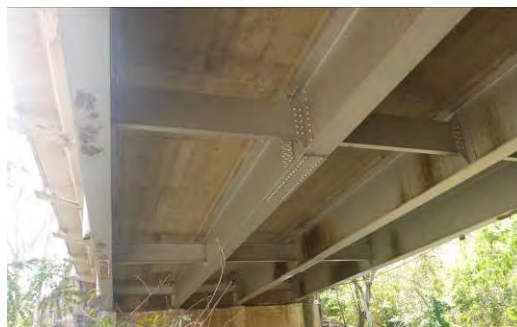
Foto 4.3.8: Puente San Nicolás, No se confirmaron avances en erosiones (Feb. 26, 2015)
