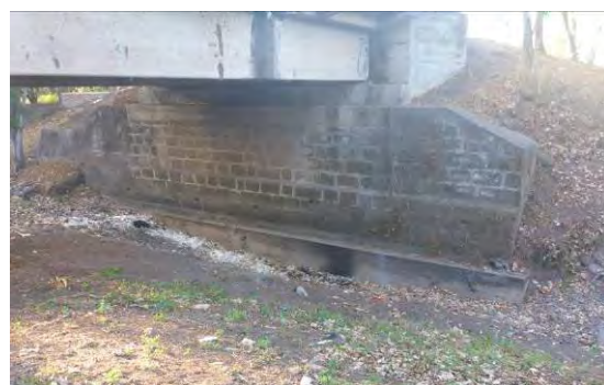
Foto 4.3.12: Puente San Ramón, No se confirmaron avances de erosiones (Feb. 26, 2015)
