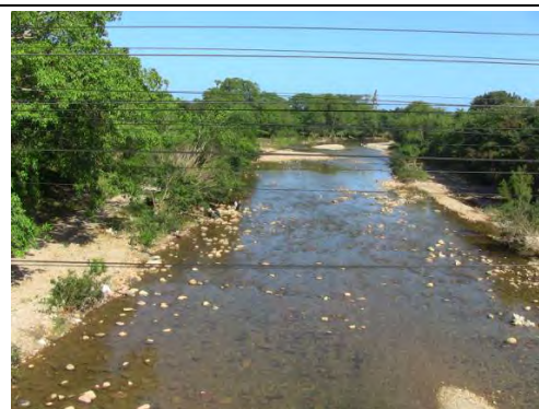
Foto 4.4.19: Río Danto (Ciudad la Ceiba), la sucursal de INSEP toma como problemática las inundaciones y la erosión de las orillas.
