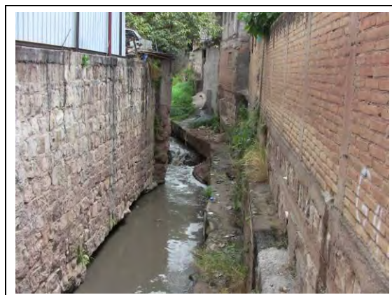
Foto 4.4.14: Río Jucos (ciudad Tegucigalpa) Situación de acercamiento de las viviendas hacia la vía fluvial
