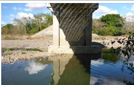
Foto 4.3.9: Puente Tacapali, Realizadas las medidas ante erosión (Feb. 26, 2015)
