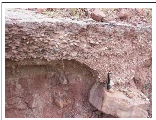
Foto 4.4.2: Relleno del suelo con escombros volcánicos verificado en la escarpa de la fotografía a la izquierda
