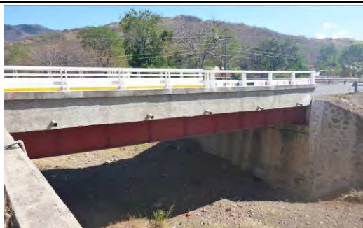
Foto 4.3.7: Puente El Guayacán reconstruido (Feb. 26, 2015)
