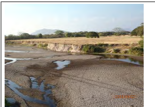
Foto 4.4.15: Punto del puente Marcovia, vía fluvial casi seca, se nota la erosión de las orillas (Fotografía de la misión de estudio)
