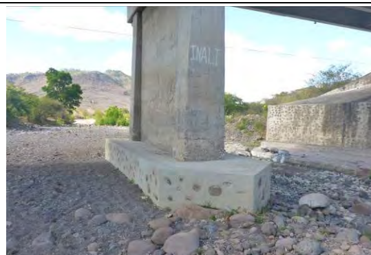
Foto 4.3.10: Puente Inali, Realizadas las medidas ante erosión (Feb. 26, 2015)
