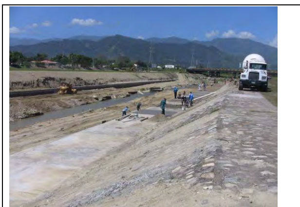
Foto 4.4.10: Obras estratégicas de emergencia ante el descenso del cauce en cercanías del puente (Tramo puente CA5 – puente férreo)
