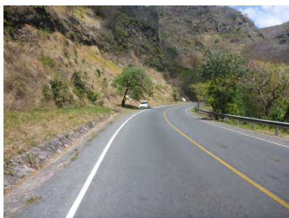
写真 N2.5：道路状況 起点側より撮影 (2015/3/16)
