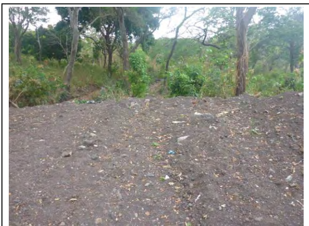
写真 E4. 11: 重機によって押し出された土砂 通行止めによる孤立集落はないとのこと (2015/3/25)
