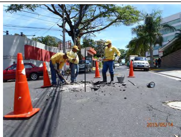
写真 E7. 2: 同路上での地下空洞部雨水排水管取り換え作業。(2013/5/14)
