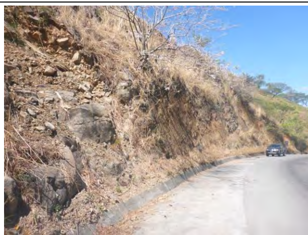
写真 E6. 12：斜面 1 右側斜面（斜面高 25m 幅 100m）（2015/2/19）
