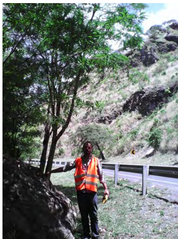
写真 N2.10: 道路谷側の転石 1.5m x 1.3m x 0.9m (2015/6/2)
