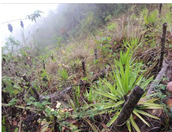
写真 E1.3: ラス・ラハス溪流 源頭部。2011年にMOPTVDUが実施した編柵工と緑化による崩壊地拡大に対する対策、緑化は成功している。(2015/4/15)
