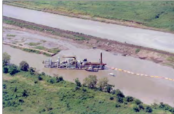
写真 H9.2: 洪水放水路の浚渫
