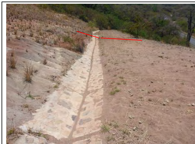
写真 N1. 9: 水路の押し出し(赤い線が地すべり右縁部) (2015/3/16)
