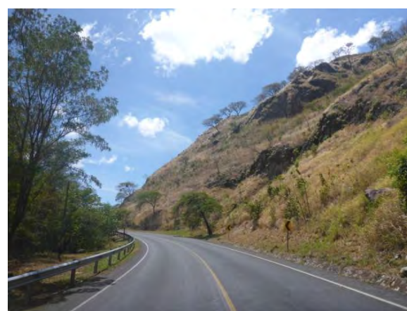
写真 N2.6：道路状況 終点側より撮影 (2015/3/16)
