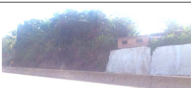
写真 E5.3: 斜面2 下り路線側斜面 (斜面高最高 10m、平均斜面高 6m、斜面道路脇延長 140m) 風化した軟岩斜面、 距離表 17km+500m (2015/3/14)
