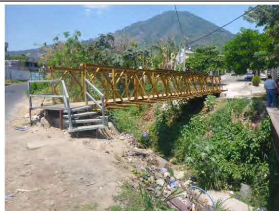
写真 E1. 12: 75 アベニダ・ノルテ道路と ブレバル・コンスティトゥション道路間、カーレ・プリンシパル道路と交差するカーレ・セビラ道路の仮橋 土石流によって流されて、仮設として設置された。(2015/3/24)
