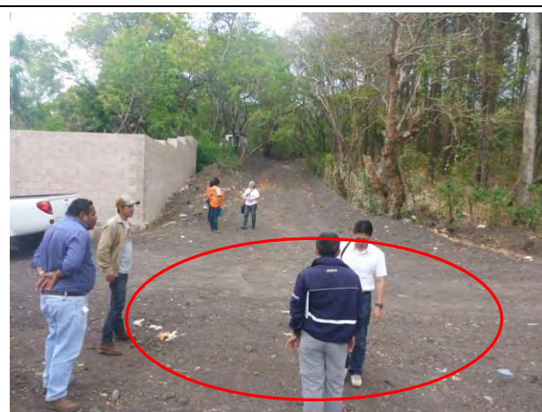
写真 E4. 10: 横断する道路に土砂が毎年堆積している。赤丸付近 (2015/3/25)
