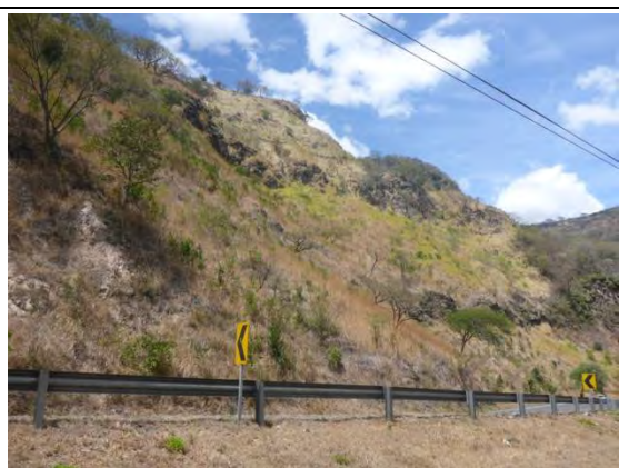
写真 N2.3：クカモンガ地区斜面 起点側より撮影 不安定な土砂、岩塊が斜面中腹に残存する。 (2015/3/16)
