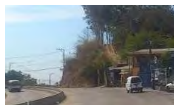
写真 E5.6: 斜面4 下り路線側斜面 (斜面高最高 15m、平均斜面高 10m、斜面道路脇延長 140m) 風化土斜面 距離表、17km+600m (2015/3/14)
