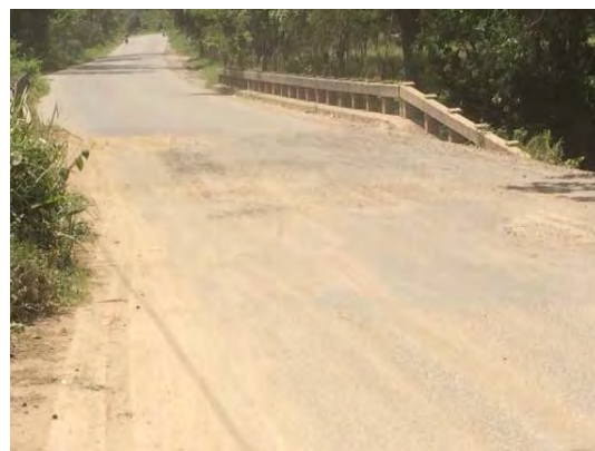
写真 H6. 2: タウヒカ橋 落橋した橋の上部を盛り土して橋面を補修している。
