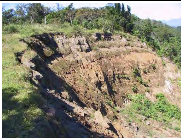
写真 E2. 2:頭部の状況 写真提供 福岡 浩教授
