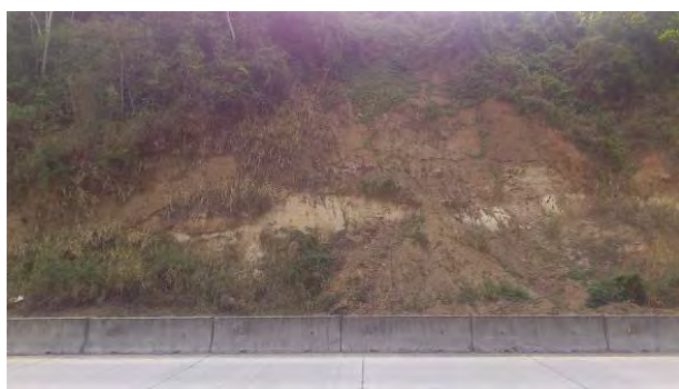
写真 E5.1: 斜面1 上り路線側斜面 (斜面高最高 21m、平均斜面高 15m、斜面道路脇延長 100m) 風化した軟岩斜面、 距離表 14km+500m (2015/3/14)
