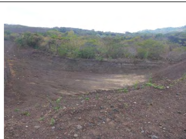
写真 E4. 3:遊砂池のポケットの状況 MOP が毎年ポケットを維持管理しているとのこと 遊砂池は 10 箇所程度設置されている (2015/3/25)
