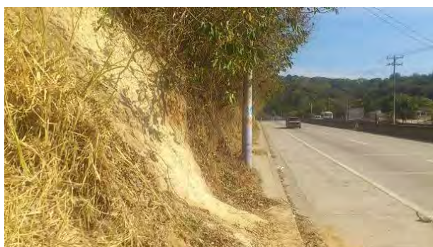
写真 E5.3: 斜面2 下り路線側斜面 (斜面高最高 10m、平均斜面高 6m、斜面道路脇延長 140m) 風化した軟岩斜面、 距離表 17km+500m (2015/3/14)
