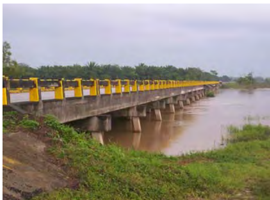
写真 H5. 1: アリビオ・デル・アグアン No. 4 橋 洪水時のアグアン川の状況。出典：INSEP Bridge Inventory Sheet
