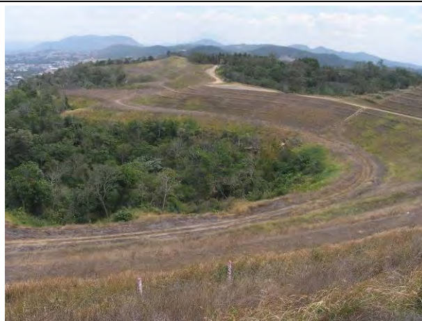
写真 E2. 4: 頭部排土の状況 写真提供 福岡教授
