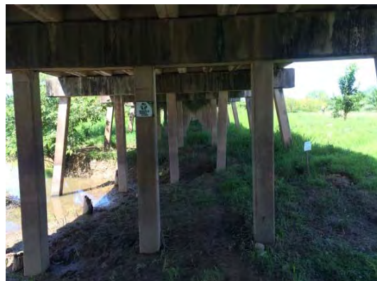
写真 H5. 2: アリビオ・デル・アグアン No. 4 橋 サバ側橋梁の橋脚状況。パイルベント橋脚ではあるが急流部でないため安定している。
