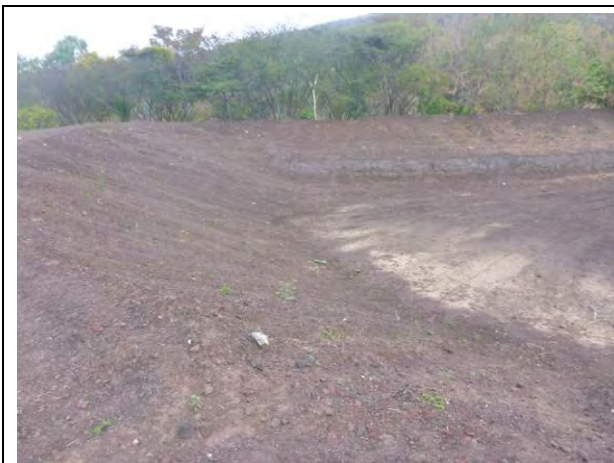
写真 E4. 2:遊砂池のポケットの状況 MOP が毎年ポケットを維持管理しているとのこと (2015/3/25)
