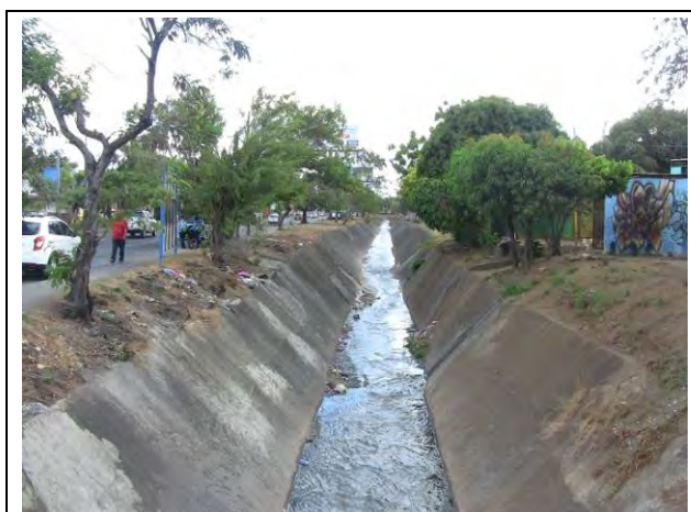
写真 N7.3: Oriental Canal 中流 (1970 年代建設)
