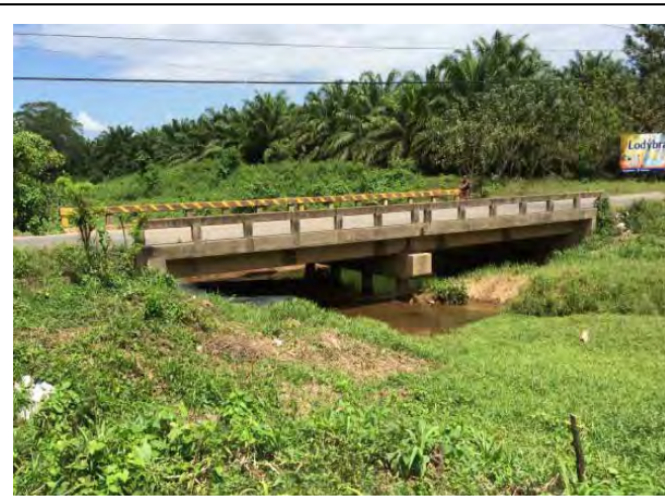
写真 H8.4: ピレス No. 2 橋 橋梁周辺は低地のため、洪水時に冠水する。トコア橋と水系が同じで、トコア川の水位の上昇により冠水が起こると想定される。
