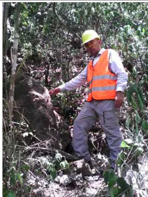
写真 N2.8: 道路谷側の転石 0.9m x 0.5m x 0.3m (2015/6/2)
