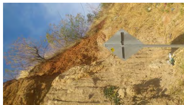
写真 E5.8: 斜面5 下り路線側斜面 (斜面高最高 22m、平均斜面高 18m、斜面道路脇延長 120m) 軟岩～風化土斜面、距離表 17km+800m (2015/3/14)
