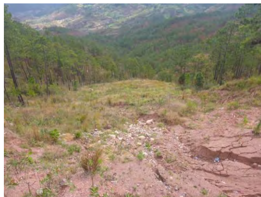
写真 H1.2: 地すべりの状況 頭部より撮影 地すべりの幅は 80m、長さは 100m と推定される。 (2015/3/6)
