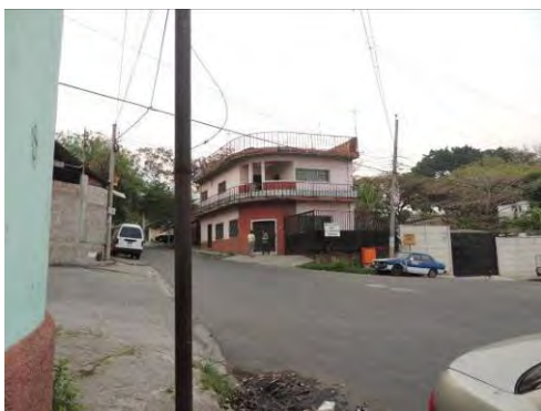
写真 E1.15: 75 アベニダ・ノルテ道路 と ブレバル・コンスティトゥション道路間、カーレ・プリンシパル道路、1982 年周辺が被災したが破壊を免れたとされるピンクの家
