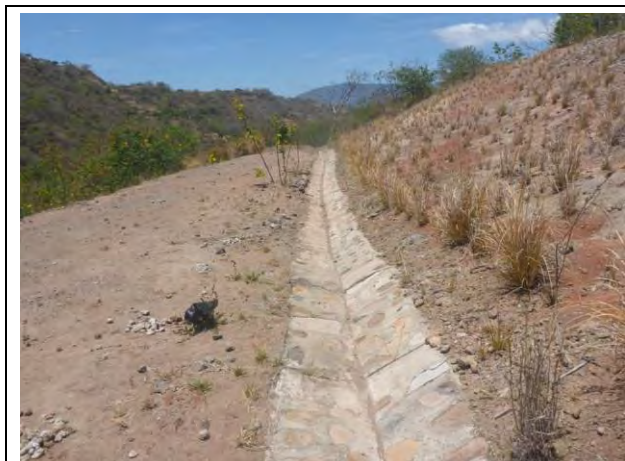
写真 N1. 7: 下から 2 段目の小段 押し出しが認められる。(2015/3/16)
