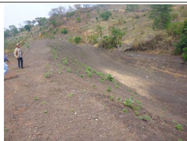
写真 E4. 5:現地発生材で作られた砂防ダム 奥側の低い部分が水通し。(2015/3/25)
