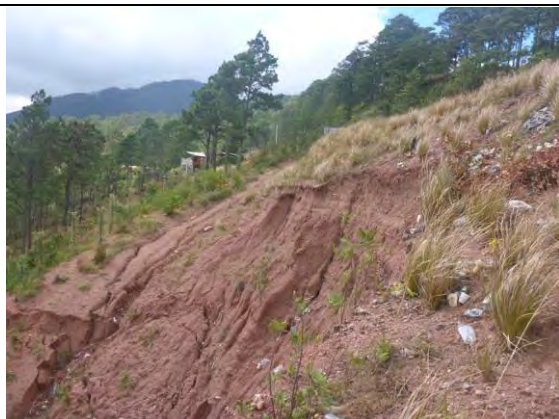
写真 H1.1: 頭部の滑落崖の状況 高さ 10m 程度 (2015/3/6)
