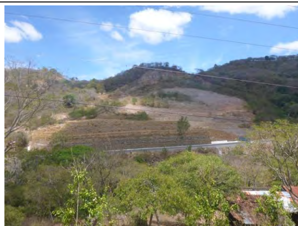
写真 N1.2: 全景 対岸斜面より撮影 (2015/3/16)
