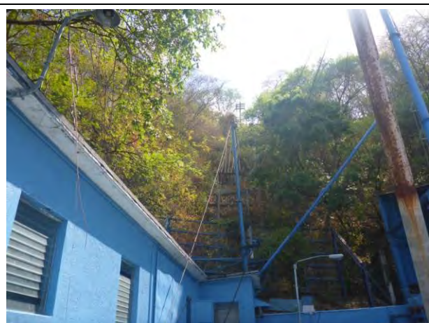
写真 N3. 5: 保全対象背後の斜面、斜面勾配は 45 度程度で斜長は 120m 程度である。 (2015/3/13)
