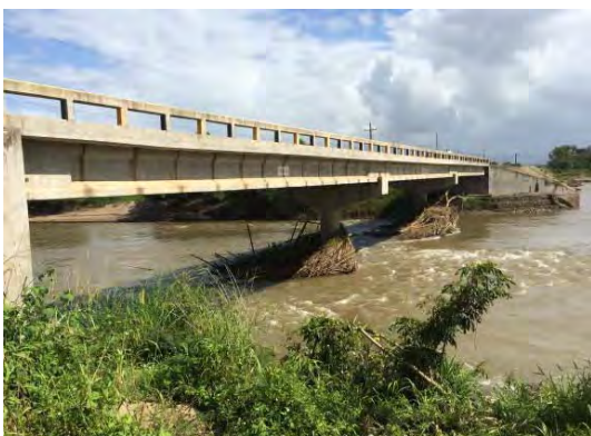
写真 H5. 6: ブッラ橋 新橋の全景。アグアン川の本流がこの橋に転流されている。
