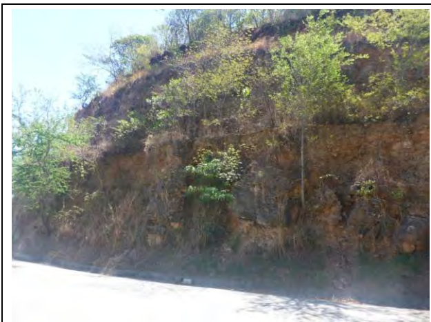
写真E6.1: 斜面9 右側斜面(斜面高10m 幅400m 部分的に法高20m 幅100m となる。) (2015/2/19)
