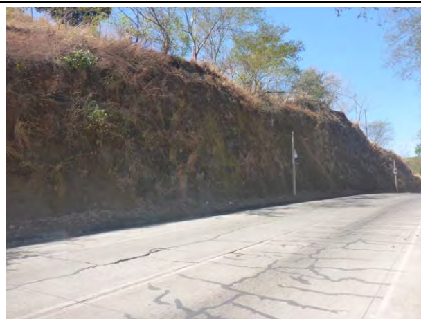
写真 E6. 8：斜面 4 左側斜面（斜面高 20m 幅 170m）右側斜面（斜面高 20m 幅 150m）（2015/2/19）
