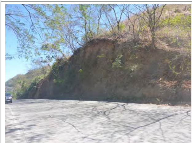
写真 E6.3: 斜面8 右側斜面(斜面高20m 幅100m) (2015/2/19)
