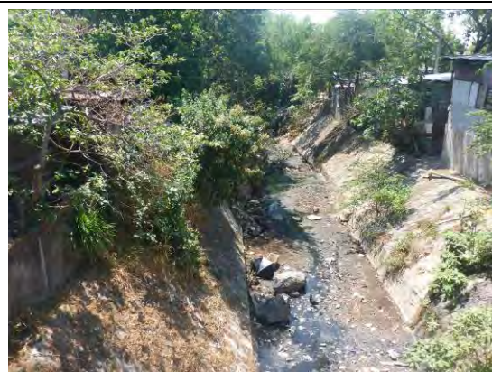
写真 E1. 11: 75 アベニダ・ノルテ道路から下流側を望む。水路の状況。(2015/ 3/24)
