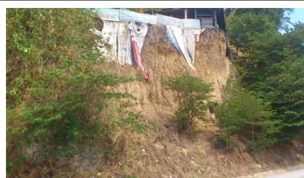
写真 E5.10: 斜面6 下り路線側斜面 (斜面高最高 11m、平均斜面高 10m、斜面道路脇延長 10m) 風化土斜面、距離表 18km+000m (2015/3/14)
