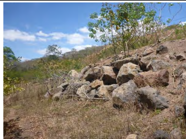
写真 N1.14：末端付近の状況 巨礫が敷設されている。(2015/3/16)
