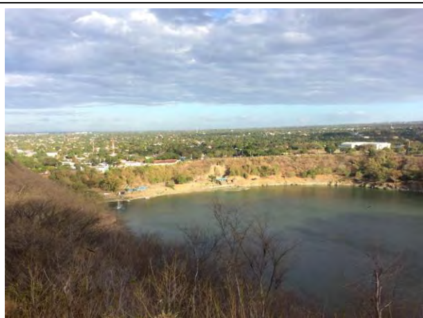
N5.1: 全景 写真中央部分が崩壊地。対岸の公園より撮影 (2015/3/2)
