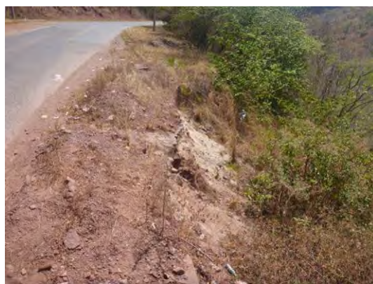
写真 H1.2：地すべり頭部の状況。地すべり頭部は路肩付近に位置する。(2015/3/6)
