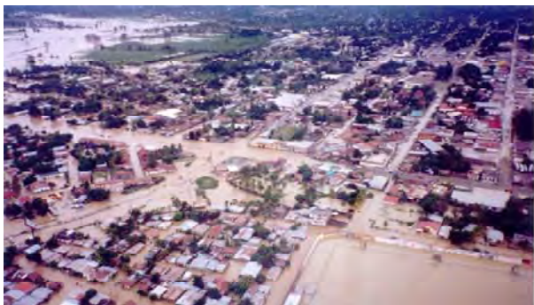
写真 H9.1: スーラバレー内のラ・リマ市における洪水氾濫被害の状況
