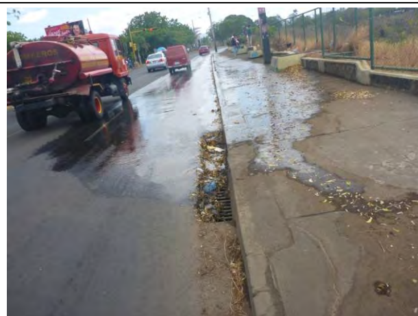
N5.4: 道路側溝の状況 (2015/3/13)
