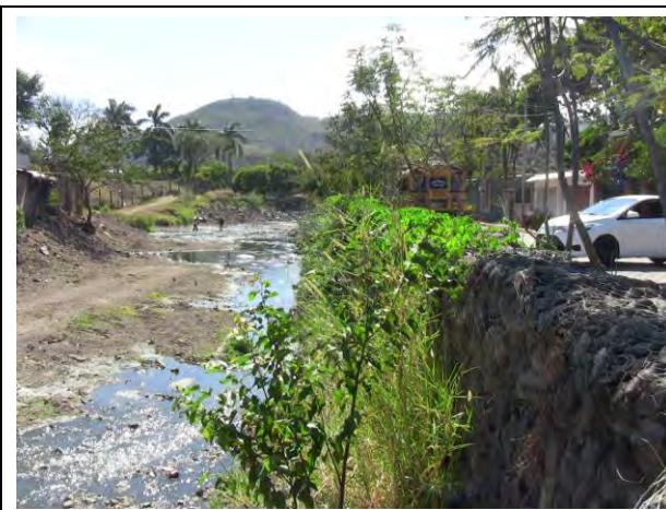
写真 N8. 2: Grande 川：2011 年から毎年河床掘削と河岸侵食対策工（蛇かご工）を実施。
