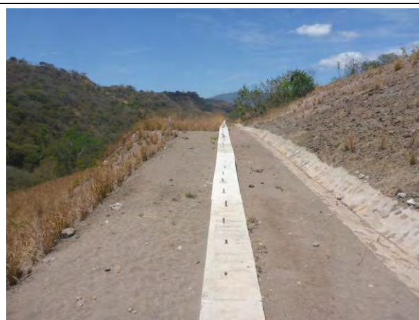
写真 N1.4: マイクロパイルの施工箇所 L=17m
