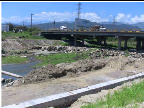
写真 4.4.8: チョロマ川 (チョロマ市) の CA-5 橋梁 撮影: JICA 調査団 2015 年 3 月
