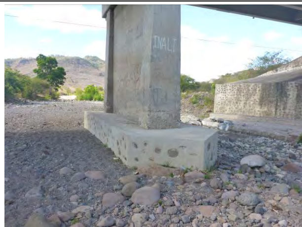
写真 4.3.10: Inali Bridge 洗堀対策実施済み (2015/2/26)
