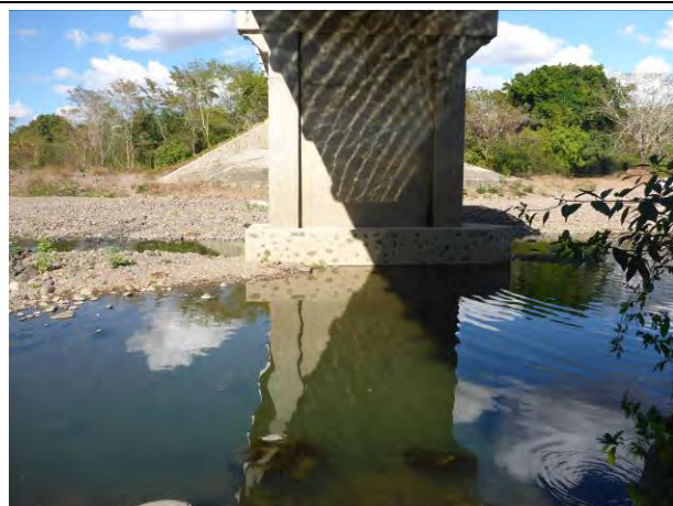
写真 4.3.9: Tacapali Bridge 洗堀対策実施済み (2015/2/26)
