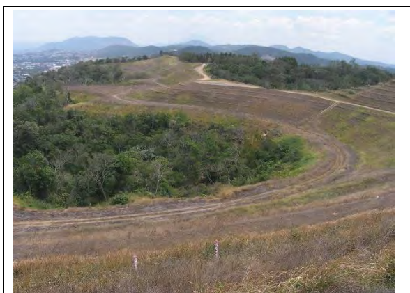
写真 4.2.7: 頭部排土後の状況 出典：環境天然資源省 (MARN)
