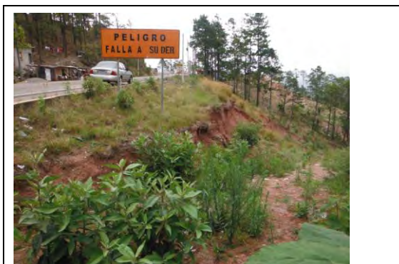
写真 4.4.3: CA-6 Sta. 14+700 地すべりの頭部滑落崖。ニカラグア側から望む。崩壊危険の注意看板が認められる
