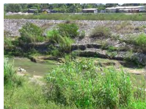
図 4.4.11: 河床低下により大きな被害を受けた護岸工 (鉄道橋の約 100 m 下流)
