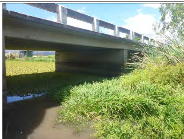
写真 4.3.13: Junqillal Bridge 浸食等の進行は認 められなかった (2015/2/26)
