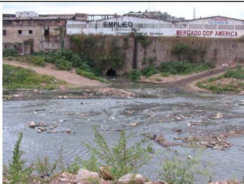
写真 4.4.13: サポ川（テグシガルパ市）の Choluteca川合流点、市場の下をトンネルにて流下させている。
