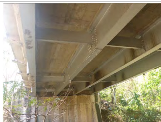
写真 4.3.8: San Nicolas Bridge 浸食等の進行は認められなかった (2015/2/26)
