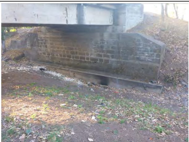
写真 4.3.12: San Ramon Bridge 浸食等の進行は認 められなかった (2015/2/26)
