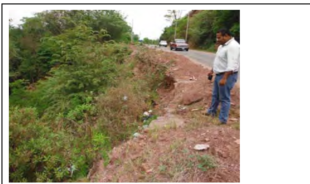
写真 4.4.1: CA-6 (Sta. 63+000) 地すべりの頭部滑落崖。ニカラグア側から望む
