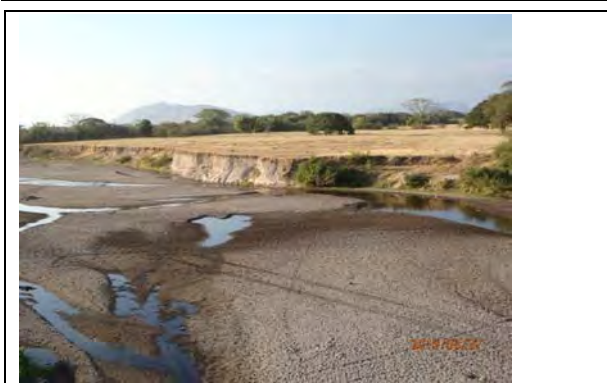
写真 4.4.15: チョルテカ川(26/3/2015) マルコピア橋地点、ほぼ干上がった河道、河岸の浸食が伺える。
