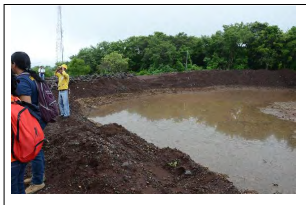
写真 4.2.12: エルサルバドル政府によって施工された遊砂地
