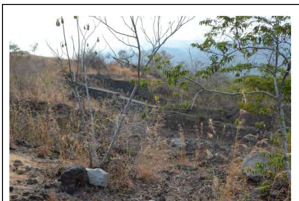
写真 4.2.11: エルサルバドル政府によって施工されたチェックダム
