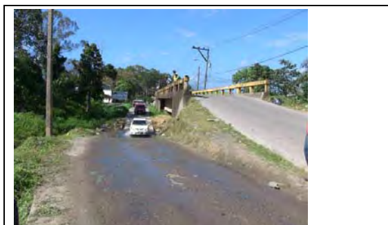
写真 4.4.18: アダン川(ラ・セイバ市)の地方自治体管理の橋梁、交通量が多いが1車線は潜水橋
