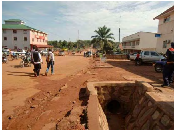
写真 15：路線 No.7 Gulu Ave. グル市の主要な流末である PECE 川につながる側溝のため、深く大きい。堆砂も取り除かれており、比較的よく管理されている。
