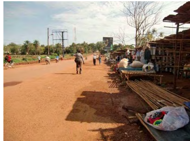
写真 16：路線 No.7 Gulu Ave. 雨期に越流すると右側の商店は冠水する。
