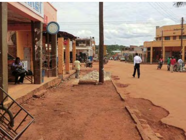
写真 17：路線 No.8 Awich Rd. 排水側溝の機能が失われており、歩道舗装はほぼ失われており、車道舗装の劣化も進行している。
