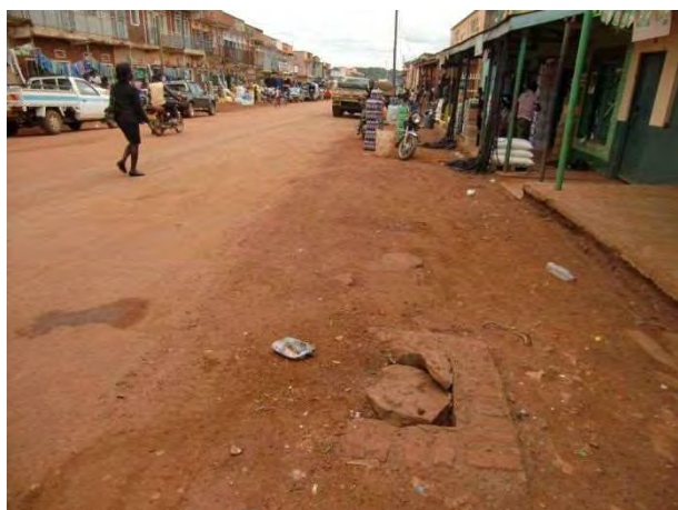
写真 21：路線 No.10 Keyo Rd. 市内中心部の路線の一つであり、両側に商店が続くが、縁石がないために舗装部と車道部の区分が明確でない。
