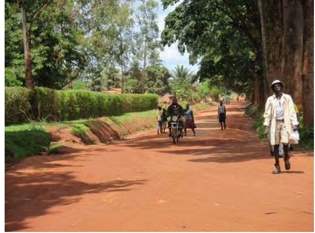
写真 26：路線 No.16 Lumumba Ave. グル市の中心市街地からやや外れた地区の路線。スタジアムが近くにあるため、イベント時は交通量が増える
