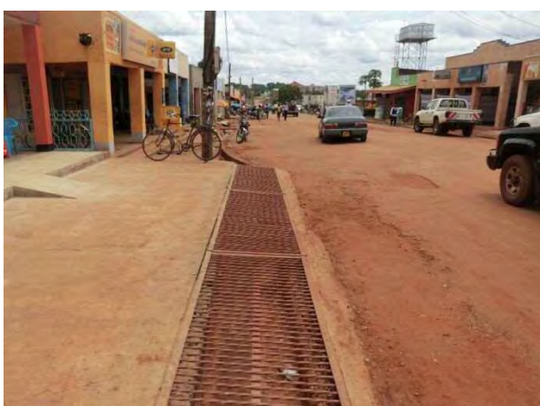
写真 23：路線 No.12 Labwor Rd. 市内中心部の路線の一つである。写真にあるように、車道と歩道の区分が明確でなく、歩行者の安全確保が十分でない
