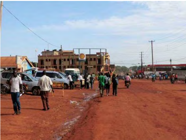
写真 1 : No.1 Kampala Rd. 車道舗装と歩道舗装がほぼ失われている
