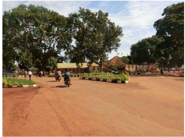
写真 14：路線 No.7 Gulu Ave. No. 7 の終点部でラウンドアバウトになっている。舗装は比較的健全
