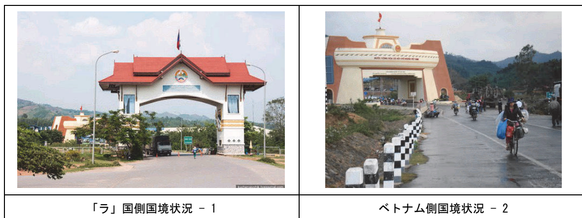
図 3. 2. 25 現状の国境施設
