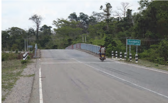
写真-1：セクムカーム橋セノ側アプローチ道路
