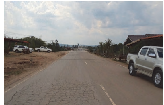
写真-8：セタームアック橋ピン側アプローチ道路
