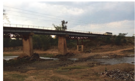
写真-6：既存セタームアック橋(1)
