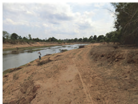
図 2.2.37 下流側河岸状況
