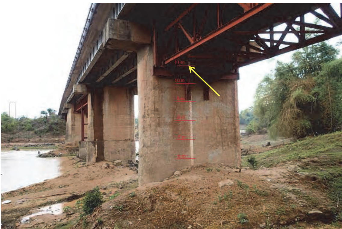
図 2.1.6 セタームアック橋の高水位記録（仮桁支保下端：高水位、黄色矢印：11.0 m）
