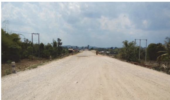
写真-5：セタームアック橋セノ側アプローチ道路
