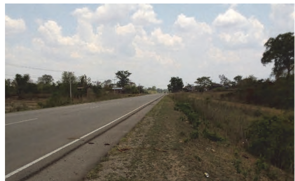
写真-4：セクムカーム橋ピン側アプローチ道路
