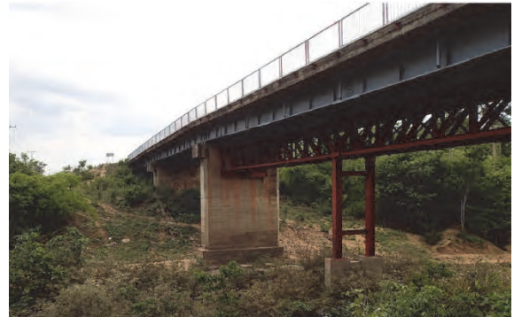
写真-2：既設セクムカーム橋(1)
