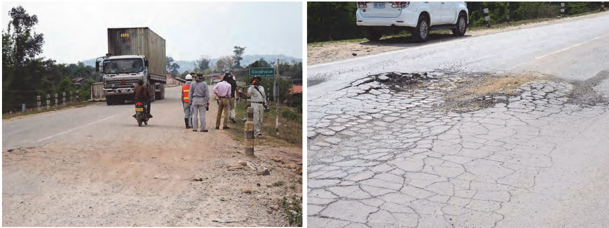
図 2.2.61 セタームアック橋取付道路の路面損傷
