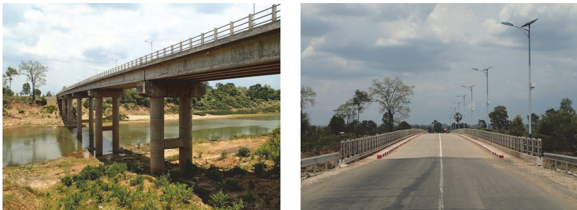
図 3.2.7 現地業者による橋梁技術（15A セドン橋）
