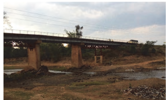
写真-6：既存セタームアック橋(1)
