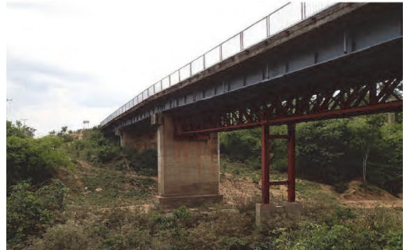
写真-2：既設セクムカーム橋(1)
