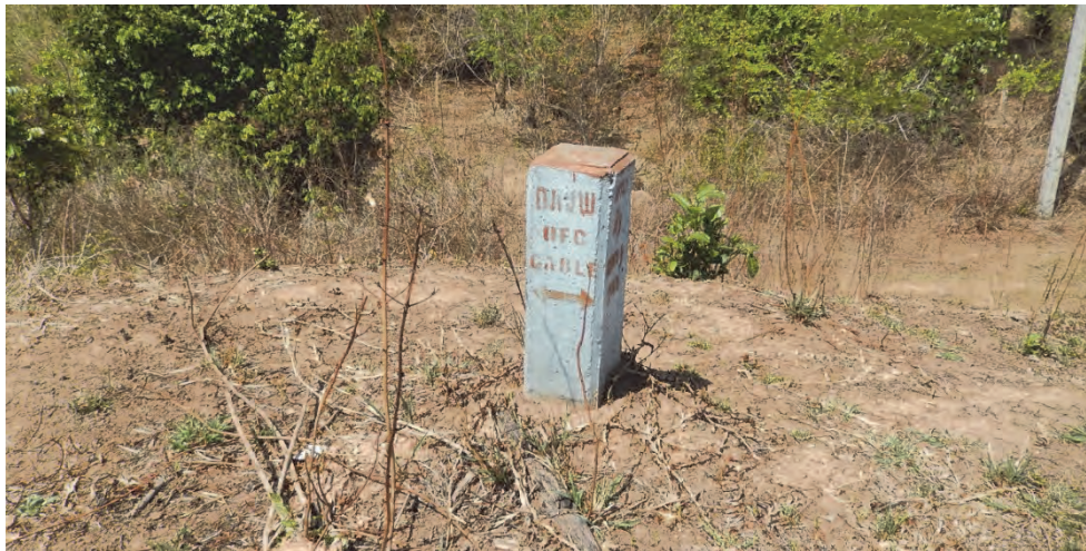
図 2.2.3 セタームアック橋下流側の光ファイバー埋設位置コンクリート杭
