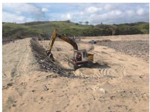
シンガトカ町の最終処分場の改善工事（2014年10月）
