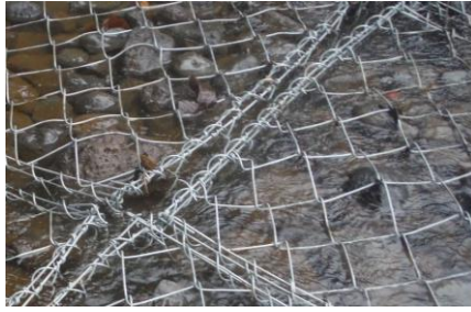
写真 10: 設置直後 (石の隙間の確認)
