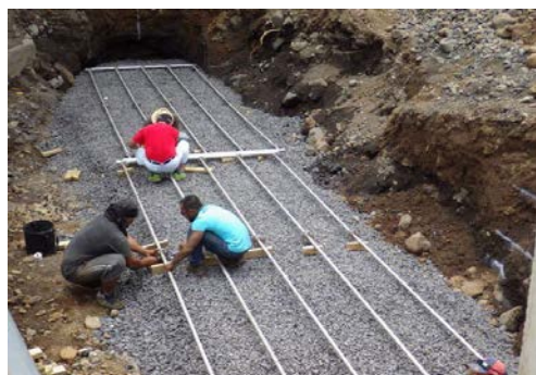
逆洗パイプの設置
