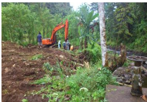
ユンボを使っでの工事区域の伐採
