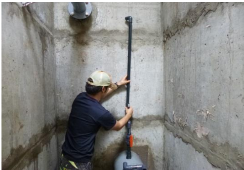
空気管設置作業
