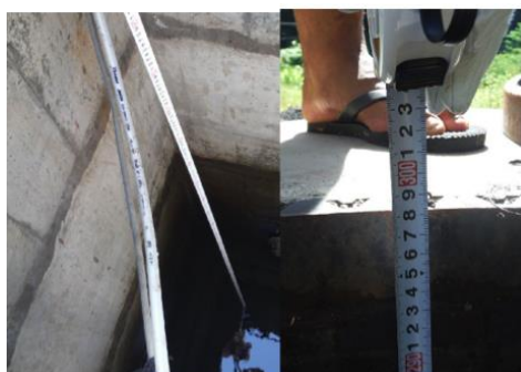
集水枠の調査
