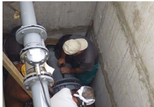
小水力発電機の設置
