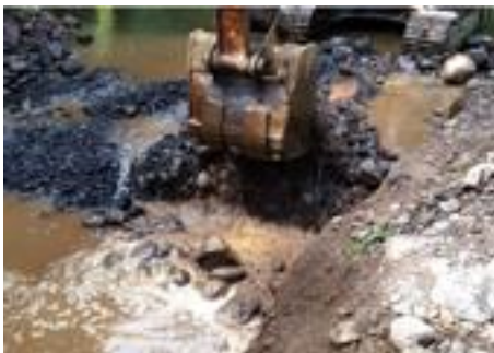
じゃ籠の取り外し、砂利層保護のためじゃ籠内の石は河川に戻して敷き均した。 写真 12: 重機を用いたメンテナンス
