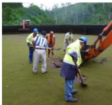
写真 18: アラオア浄水場のメンテナンス作業の様子
