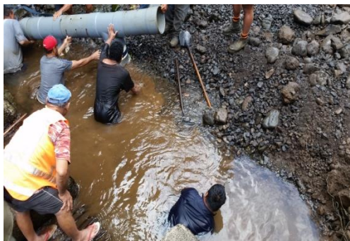
小水力発電取水管の取り外し作業
