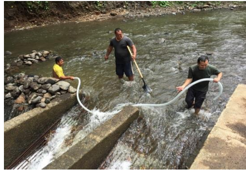
防塵網設置作業
