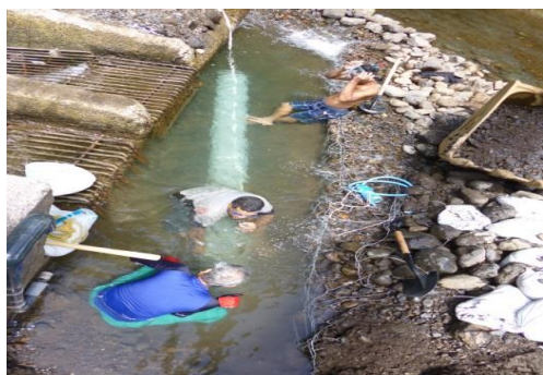
導水管撤去作業
