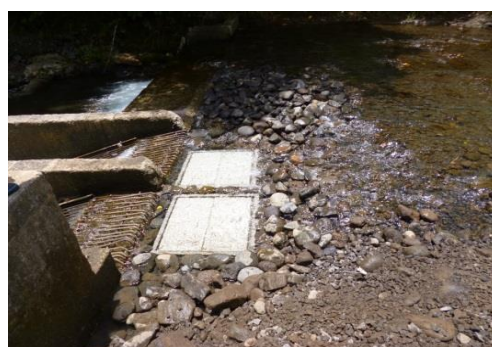
取水口柵設置
