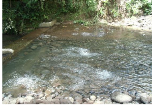
逆洗実施の様子
