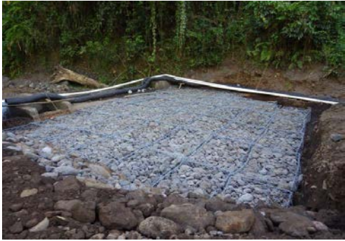
蛇籠の敷き詰め
