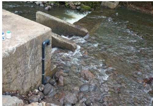
空気管設置完了後の様子
