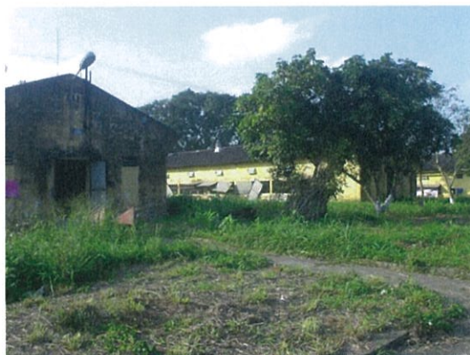
飼育棟の状況(古い施設である)
