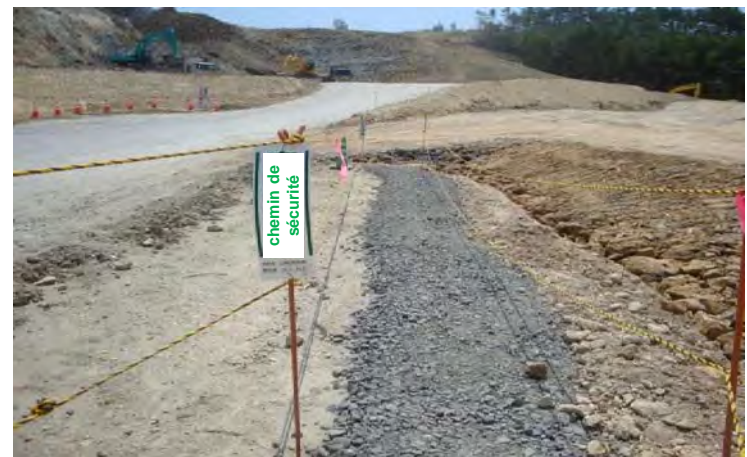
Un chemin de sécurité régulier (ne présentant pas d'obstacle à la marche à pied et indiqué avec une signalisation nette)
