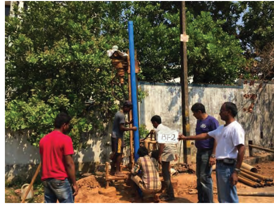
井戸ケーシング挿入の様子 (2015/3/22 撮影) ベトラ工業団地入り口そば BT-2 地点
