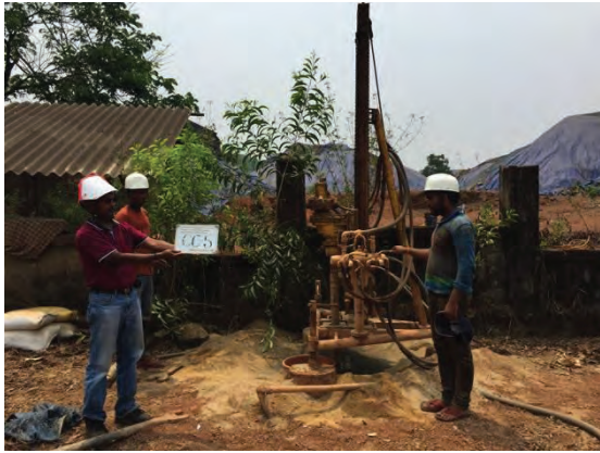
ボーリング掘削 (2015/3/20 撮影) カンコリム工業団地内、CC-5 地点
