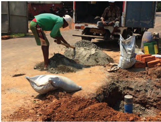
井戸仕上げの様子 (2015/3/21 撮影) ベトラ工業団地内、BT-7 地点
