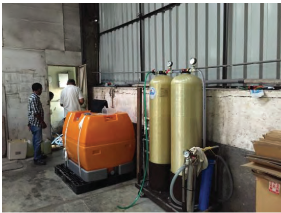
水処理設備設置の様子 (2015/12/15 撮影) ベトラ工業団地内、Aerocoach 社の排水ピット
