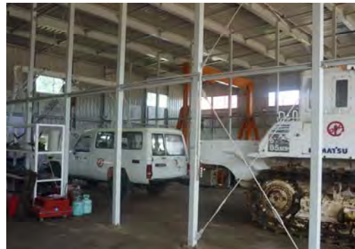
CWS の内部。維持管理工具を取り揃え、機材の維持管理作業を行える環境下にある
