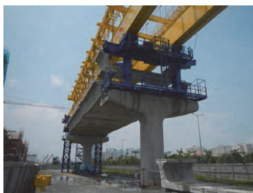
図 4-8 高架橋設置工事の様子
