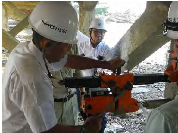
ပုံ (၃.၆) ။ Core Drilling အသုံးပြုပုံ ပြသနေပုံနှင့် သင်တန်းသားများ လက်တွေ့လုပ်ဆောင်ကြည့်နေပုံ
