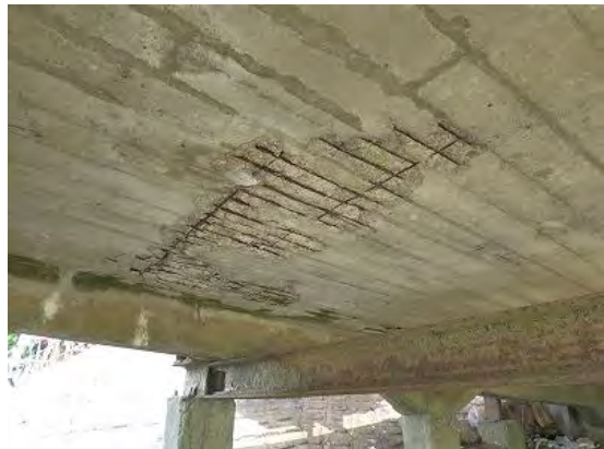
ပုံ (၃.၃၀) ။ ။ စစ်အိုးတန်းဆိပ်ခံ အမှတ်-၂ ရှိ ပျက်စီးမှု အပိုင်းများ
