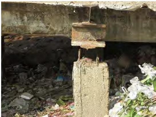
ပုံ (၃.၃၀) ။ ။ စစ်အိုးတန်းဆိပ်ခံ အမှတ်-၂ ရှိ ပျက်စီးမှု အပိုင်းများ
