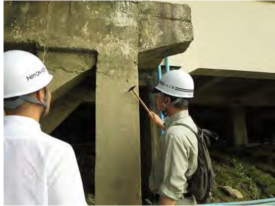
ပုံ (၃.၂၃) ။ နန်းသီတာဆိပ်ခံတံတား အမှတ် (၃)ပုံနှင့် တိုင်းတာစစ်ဆေးနေစဉ်
